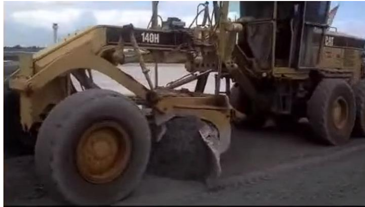
Figura 21: Máquina associada ao modelo BIM prepara o terreno sem operário. Fonte:(GRANADEIRO, 2021).
