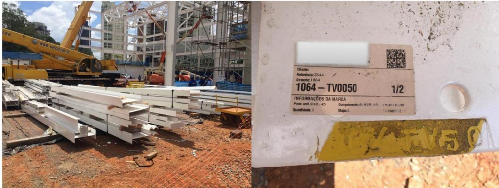
Figura 12: Peças estruturais em campo com etiquetas de identificação. Fonte: (LIMA, 2019).
