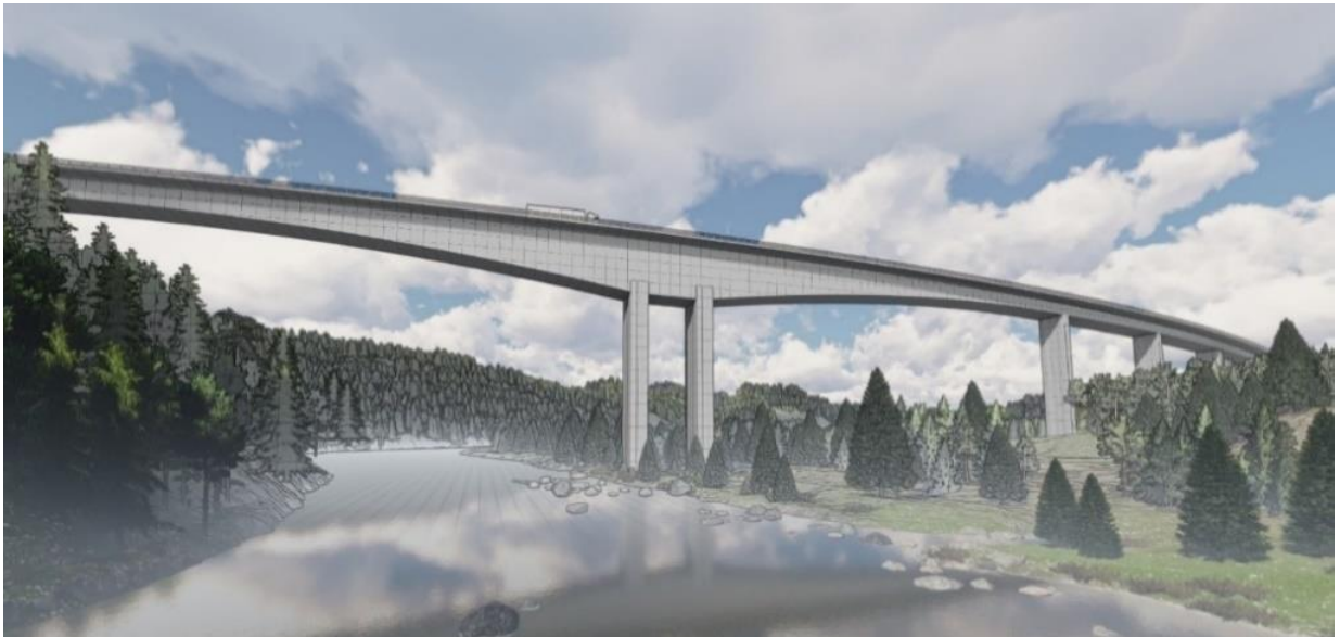
Figura 26: vista geral da Ponte Randselva a partir do Modelo 3D BIM. Fonte: (TEKLA, 2020).
