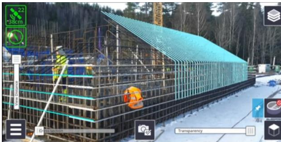
Figura 32: Detalhe de um trecho da ponte exibindo os detalhes da armação. Fonte: (NEVES, 2020).
