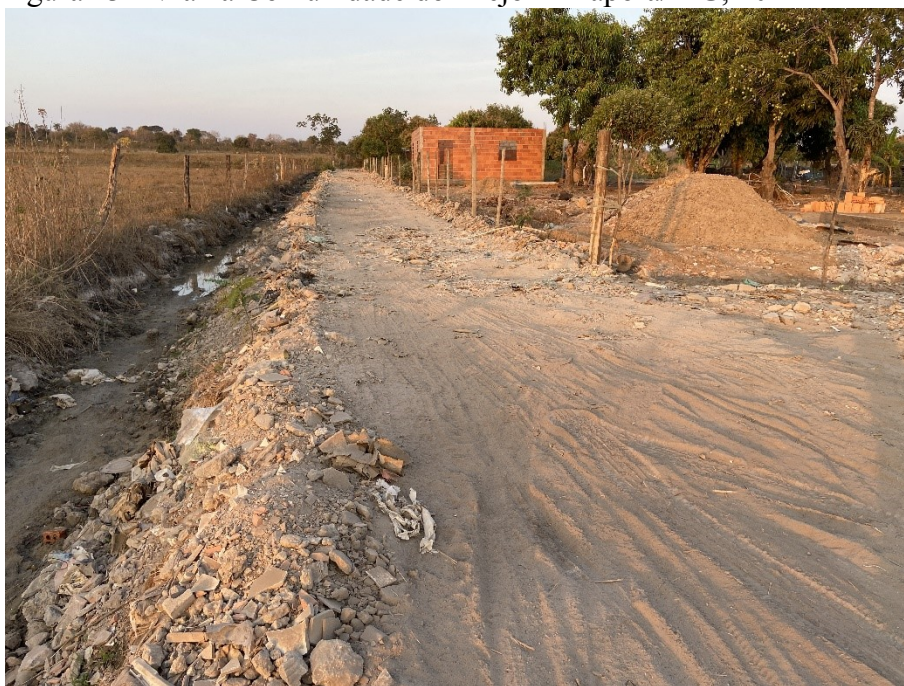
Figura 23 - Via na Comunidade do Brejo - Pirapora/MG, 2021
