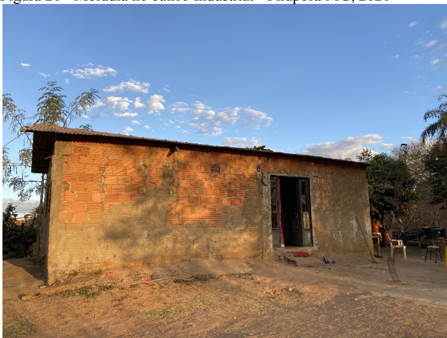
Figura 21 - Moradia no bairro Industrial - Pirapora/MG, 2021
