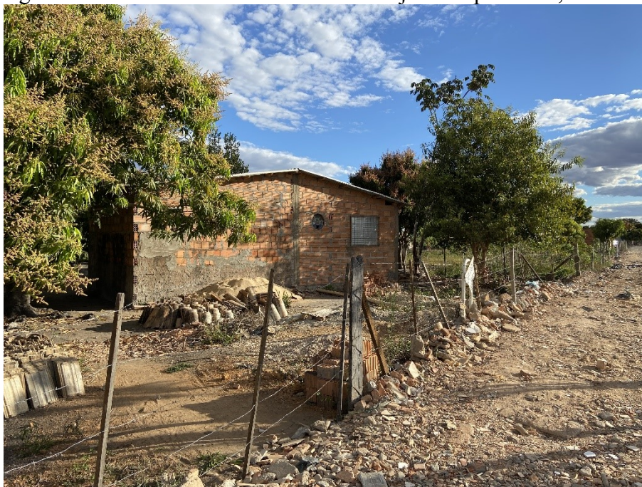
Figura 26 - Moradia na Comunidade do Brejo - Pirapora/MG, 2021
