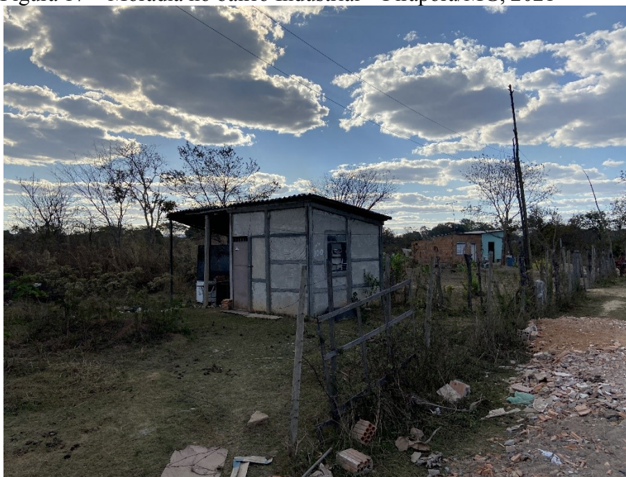
Figura 17 – Moradia no bairro Industrial – Pirapora/MG, 2021
