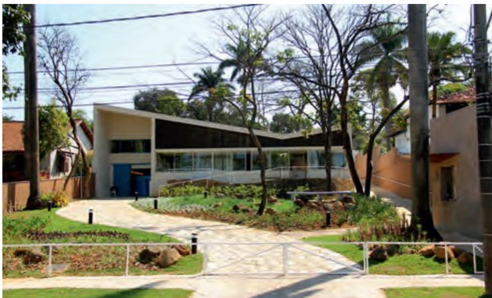
Figura 70: Vista da fachada frontal da Casa Kubitschek.
