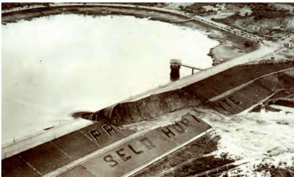
Figura 51: Rompimento da barragem da Pampulha em 1954.
