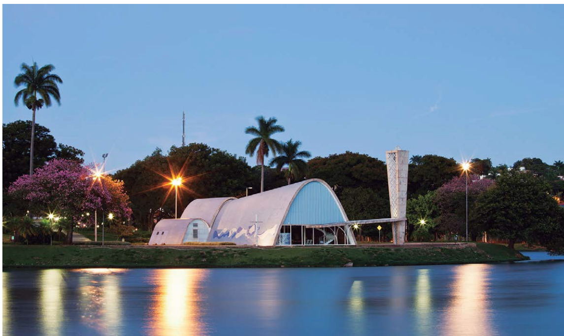
Figura 96: Vista da Igreja São Francisco de Assis.
