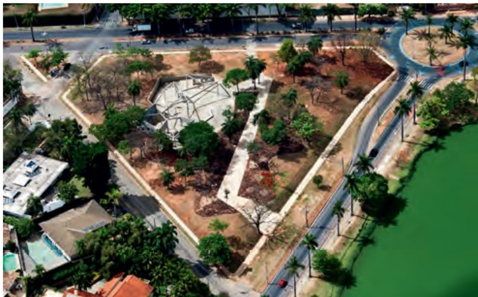
Figura 75: Vista aérea da Praça Alberto Dalva Simão em 2015, projetada por Burle Marx – Subzona de Amortecimento 2.
