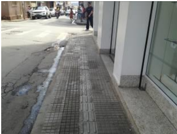
(c) calçada estreita
