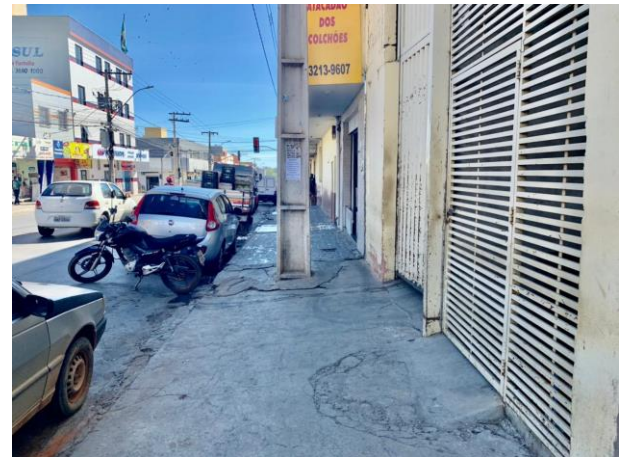
(f) obstáculo na calçada/poste
