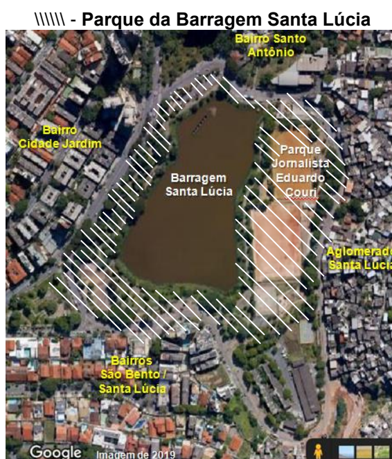
Figura 46 – Vista aérea do parque, com a barragem e bairros do entorno
