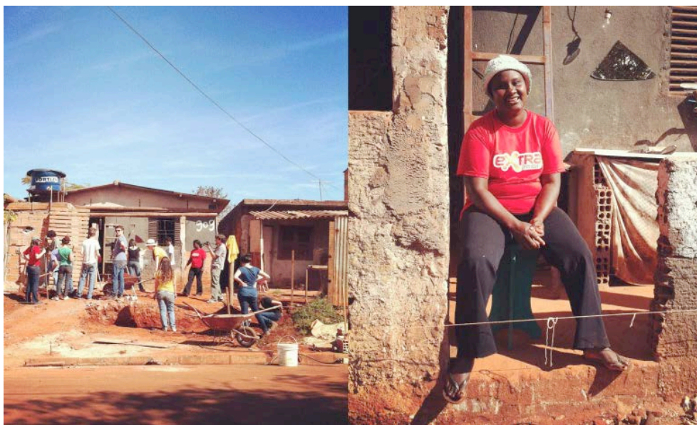
Imagem 5 – Reforma da casa da Ivete pela equipe de bolsistas de extensão da Escola de Arquitetura da UFMG e, ao lado, a própria Ivete
