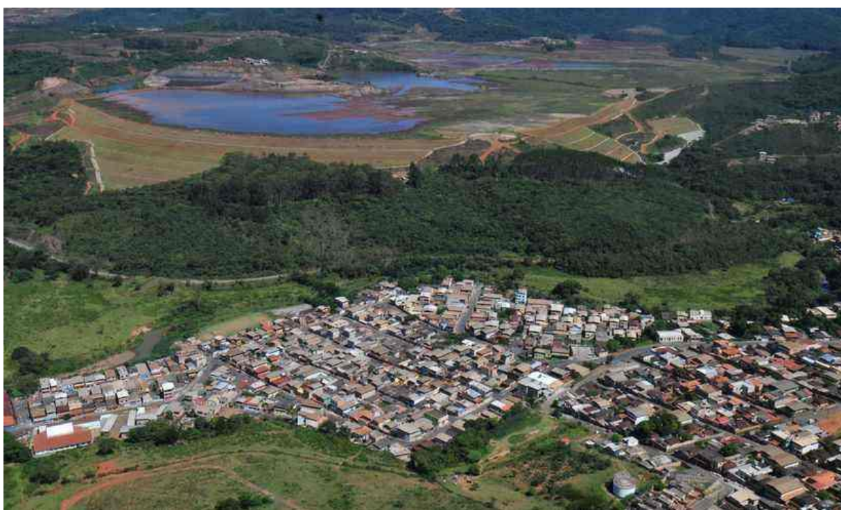
Figura 5- Barragem Casa de Pedra e sua proximidade à Congonhas.
