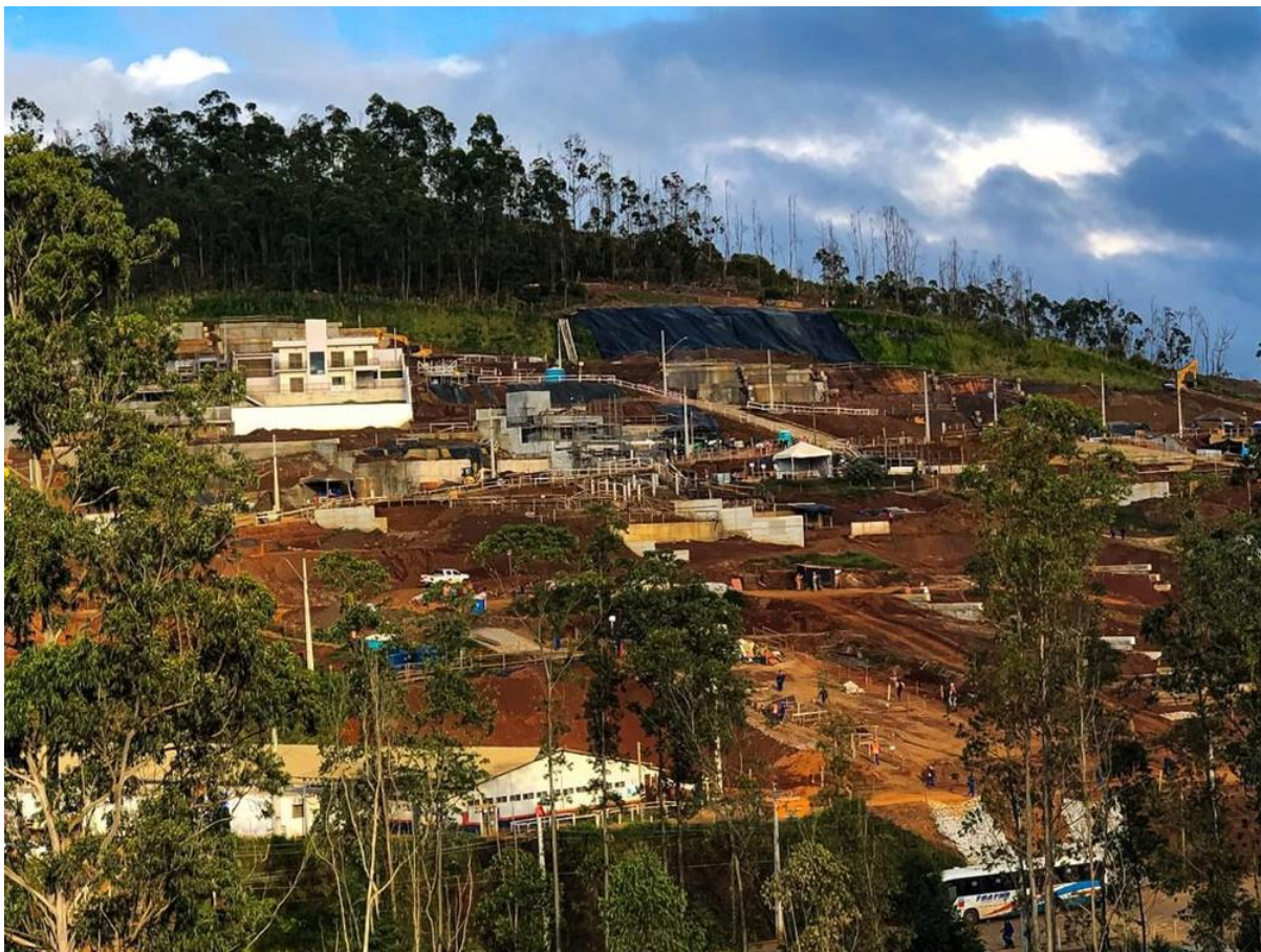
Figura 19 - Reassentamento do Novo Bento Rodrigues, onde passados 5 anos, somente 5 casas foram finalizadas.
