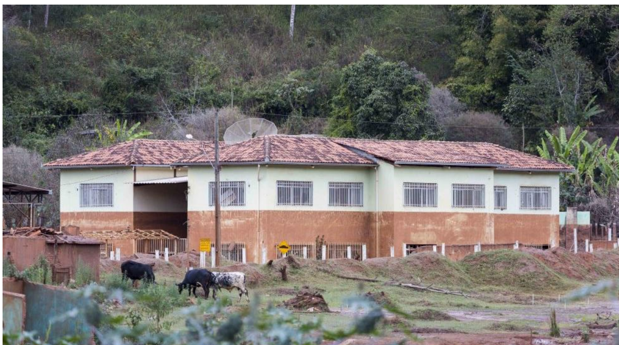
Figura 18 - Escola do Distrito de Paracatu de Baixo, depois do rompimento da Barragem de Fundão.
