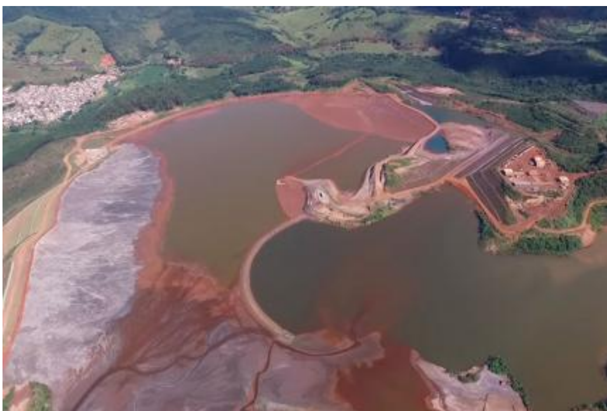
Figura 8 – Barragem de Laranjeiras, Mina de Brucutu.
