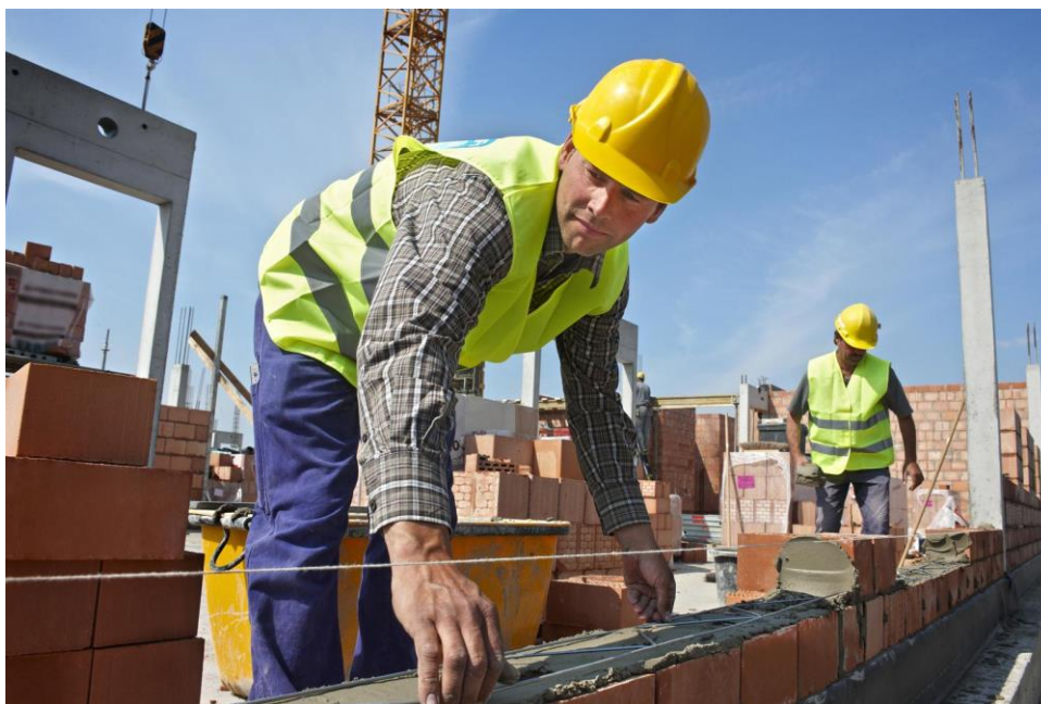
Figura 2 – Aplicação da treliça Murfor® em obra
