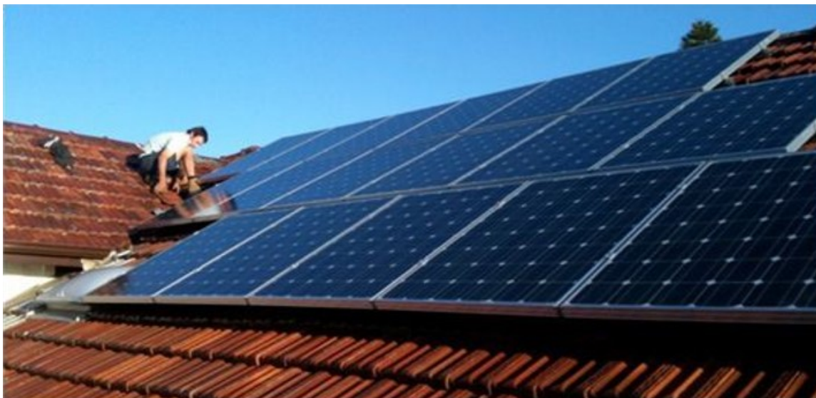
Figura 12 - Painel fotovoltaico montado em telhado
