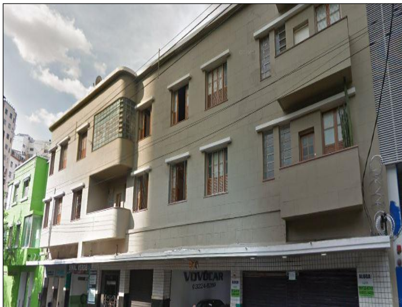
Figura 144 – Frente da edificação
