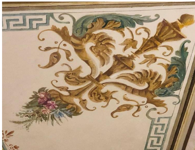
Figura 44 – Detalhe da pintura decorativa do teto
