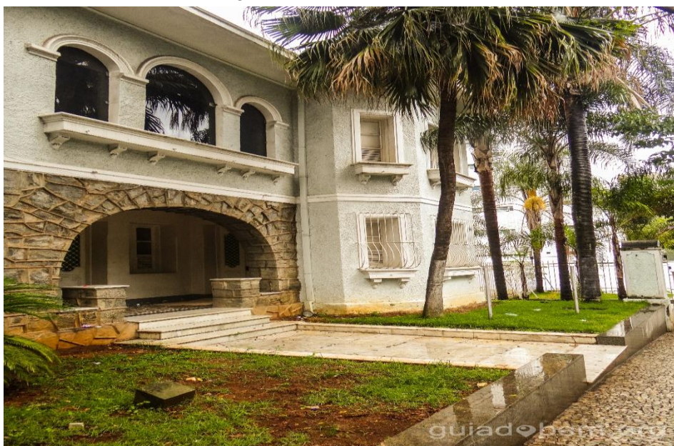
Figura 124 – Fachada da casa
