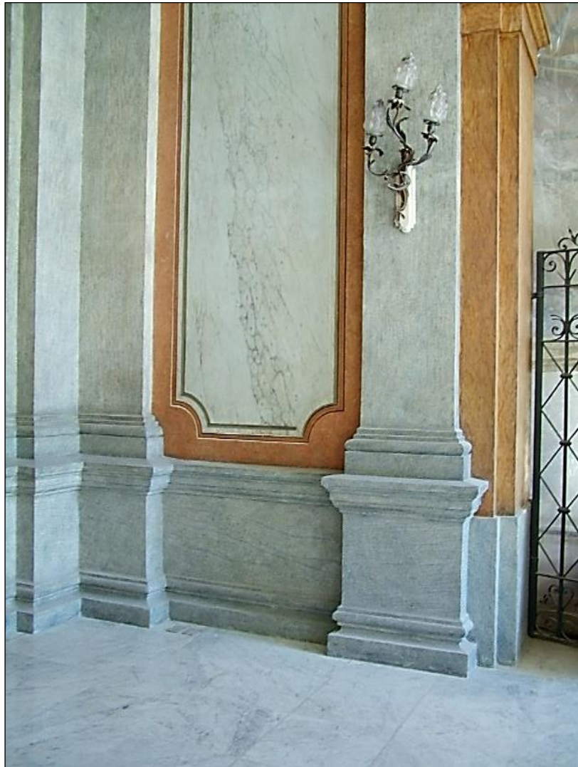
Figura 188 – Pintura de falso mármore na divisão dos vãos e colunas (Vão de entrada do Palácio da Liberdade)
