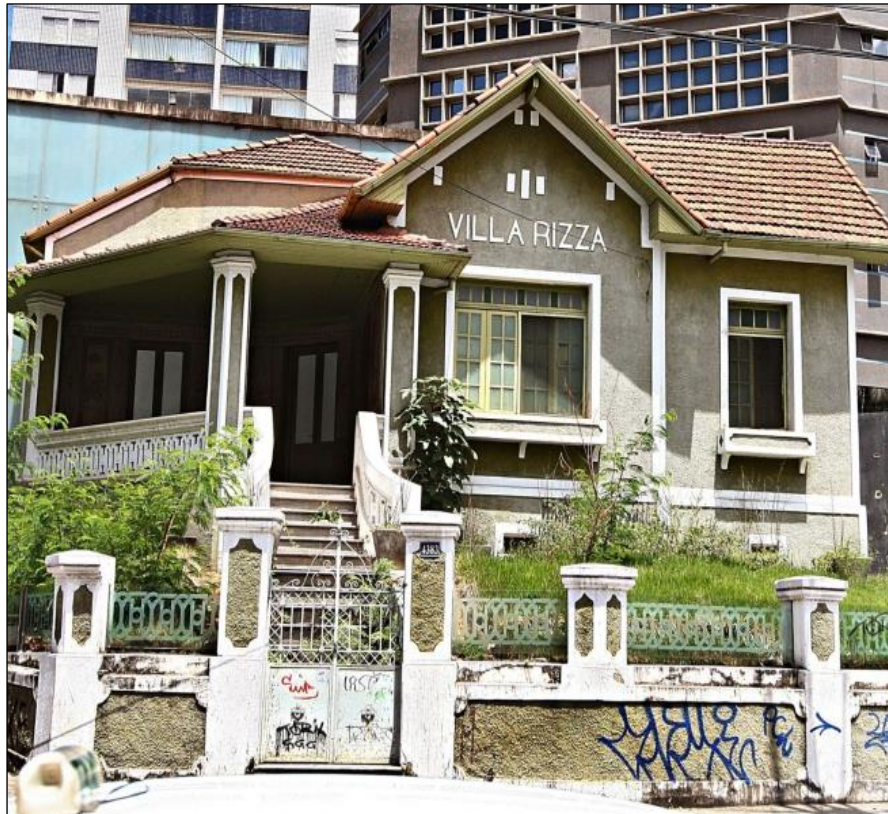
Figura 134 – Fachada frontal da Villa Rizza antes da restauração de 2020
