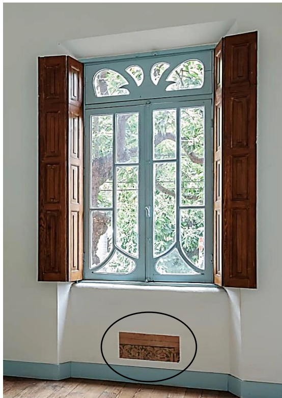
Figura 77 – Detalhe da prospecção na parede
