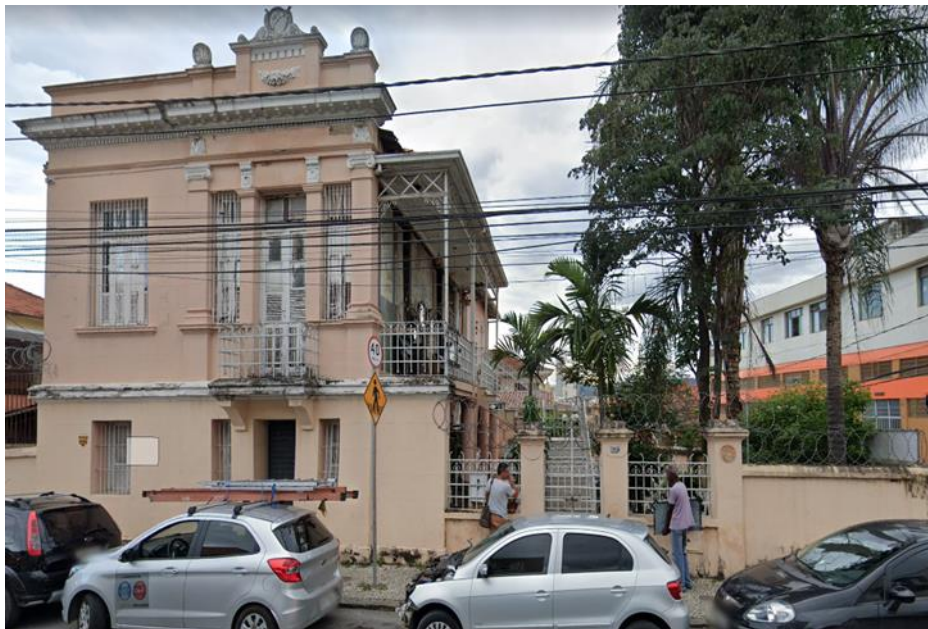
Figura 101 – Fachada frontal da edificação
