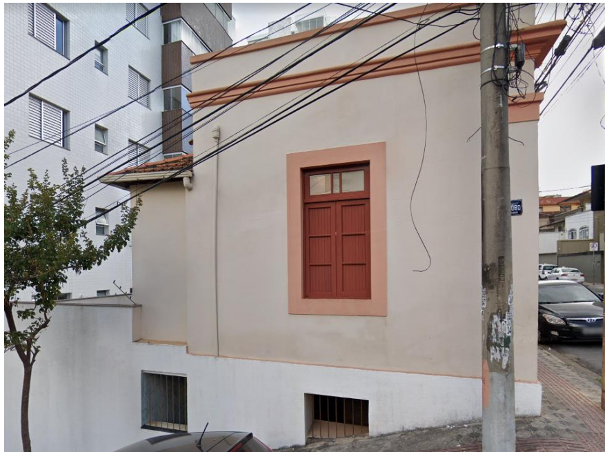
Figura 68 – Vista lateral da edificação onde se vê o porão
