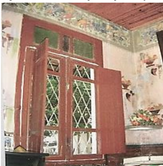
Figura 110 – Detalhe da pintura perto da janela
