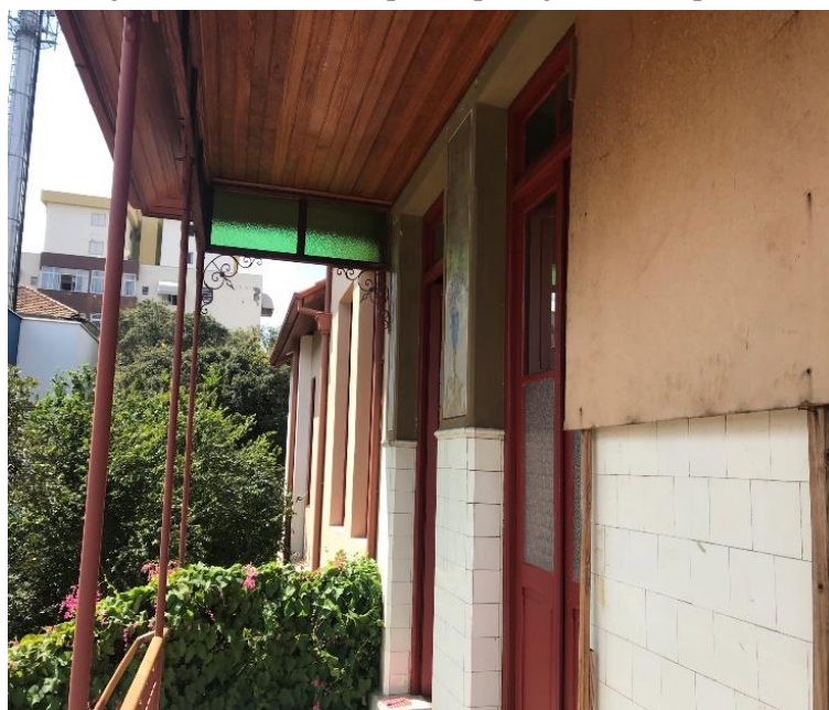
Figura 82 – Detalhe do painel protegido com tapume
