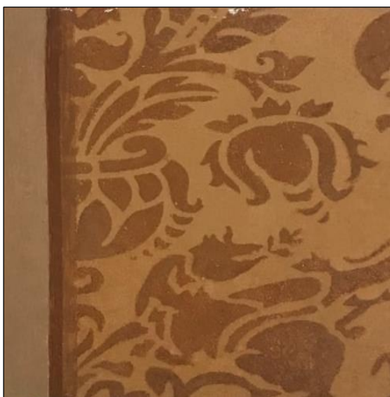
Figura 132 – Detalhe da prospecção realizada
