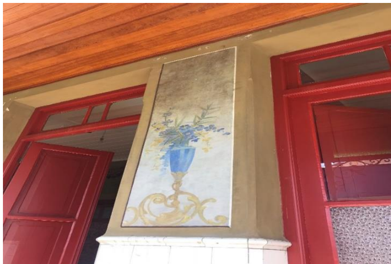
Figura 80 – Detalhe da pintura no vão das portas
