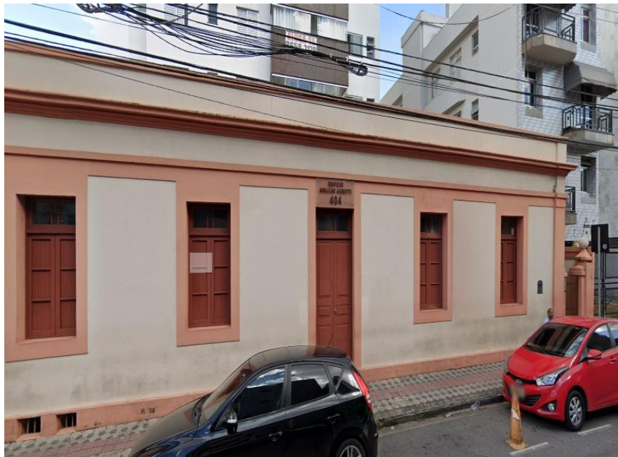
Figura 67 – Fachada da edificação
