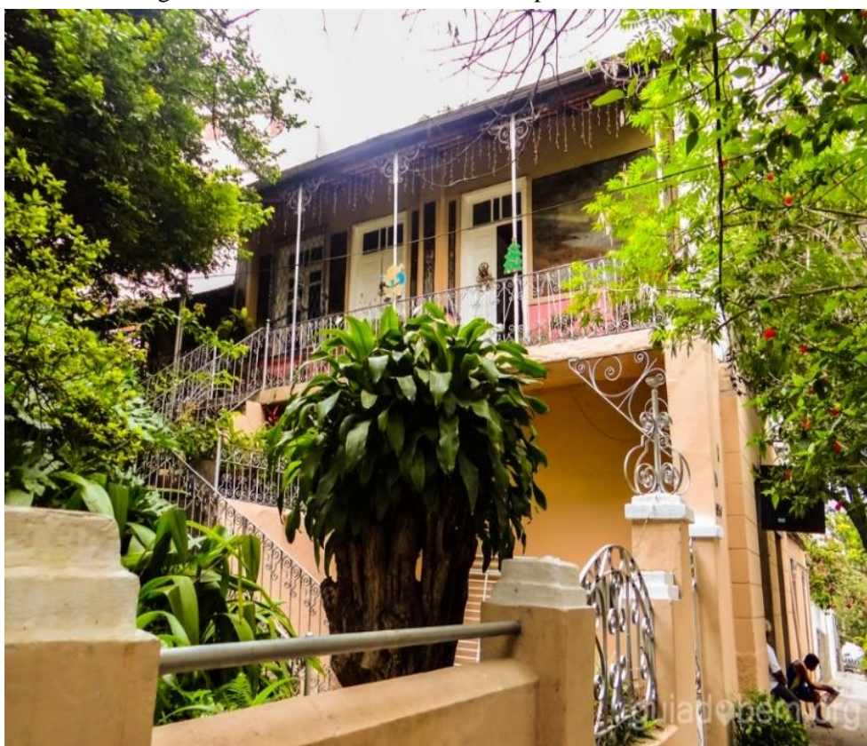
Figura 106 – Detalhe da varanda com pinturas decorativas
