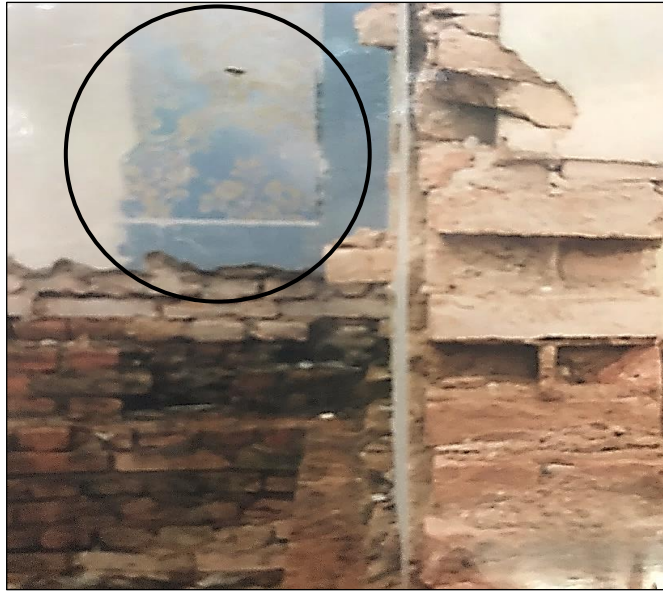
Figura 139 – Detalhe da pintura mural decorativa após início de demolição
