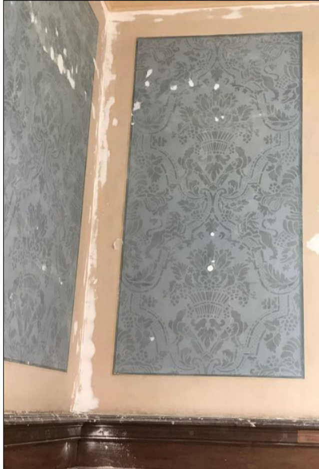
Figura 133 – Detalhe da pintura do hall de entrada após remoção
