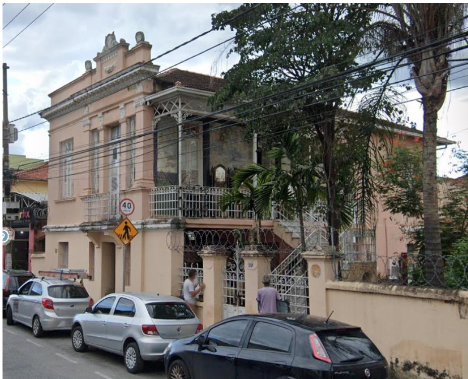
Figura 102 – Fachada lateral da edificação
