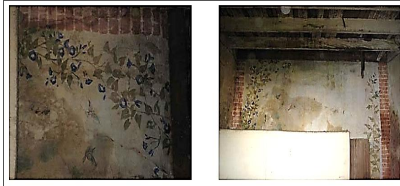
Figura 70 – Detalhe das pinturas decorativas no interior da edificação
