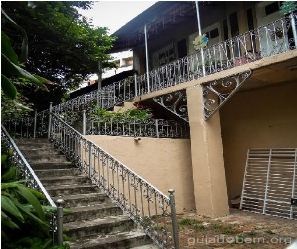
Figura 107 – Detalhe das grades e da pintura no alpendre
