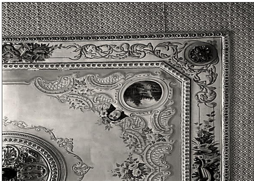
Figura 29 – Forro decorativo da casa da Rua Santa Rita Durão, 1033
