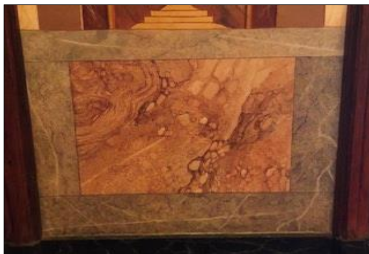
Figura 185 – Pintura de fingido de mármore do Museu das Minas e do Metal
