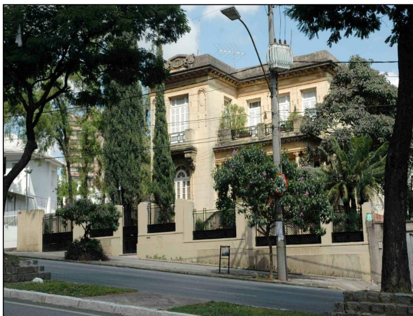
Figura 142 – Fachada frontal da edificação
