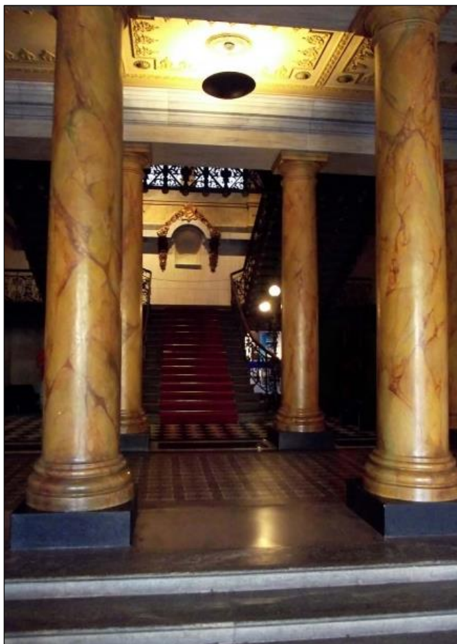
Figura 186 – Pintura imitação de mármore nas colunas da entrada do Museu das Minas e do Metal
