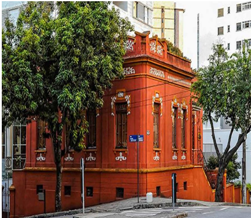
Figura 73 – Fachada lateral e frontal da edificação
