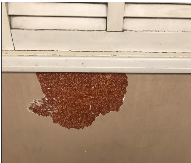
Figura 148 – Início da remoção da repintura da parede do corredor
