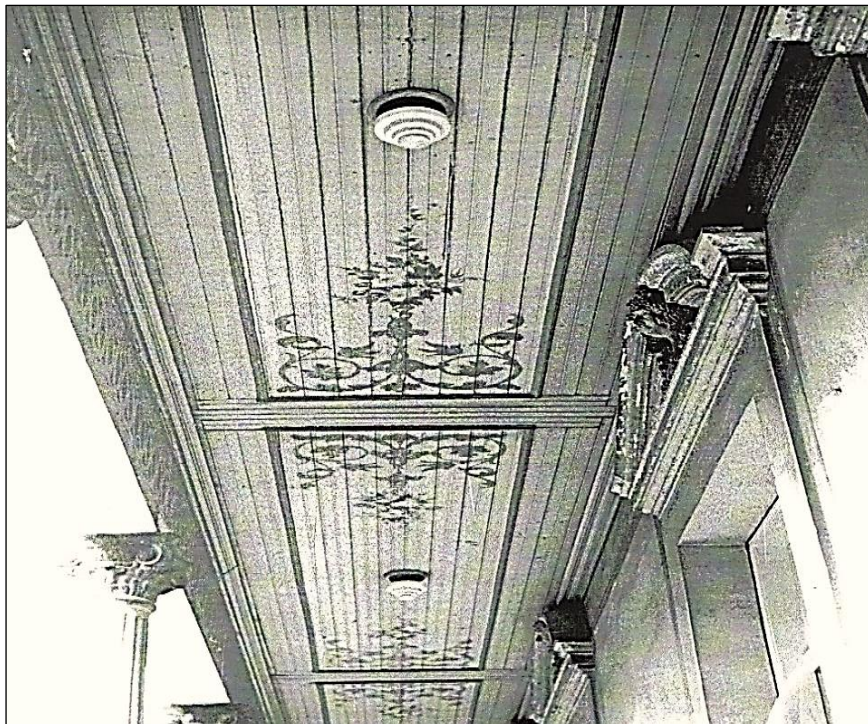
Figura 25 – Detalhe do forro do alpendre da casa da Rua Itapecerica – Casa da Loba
