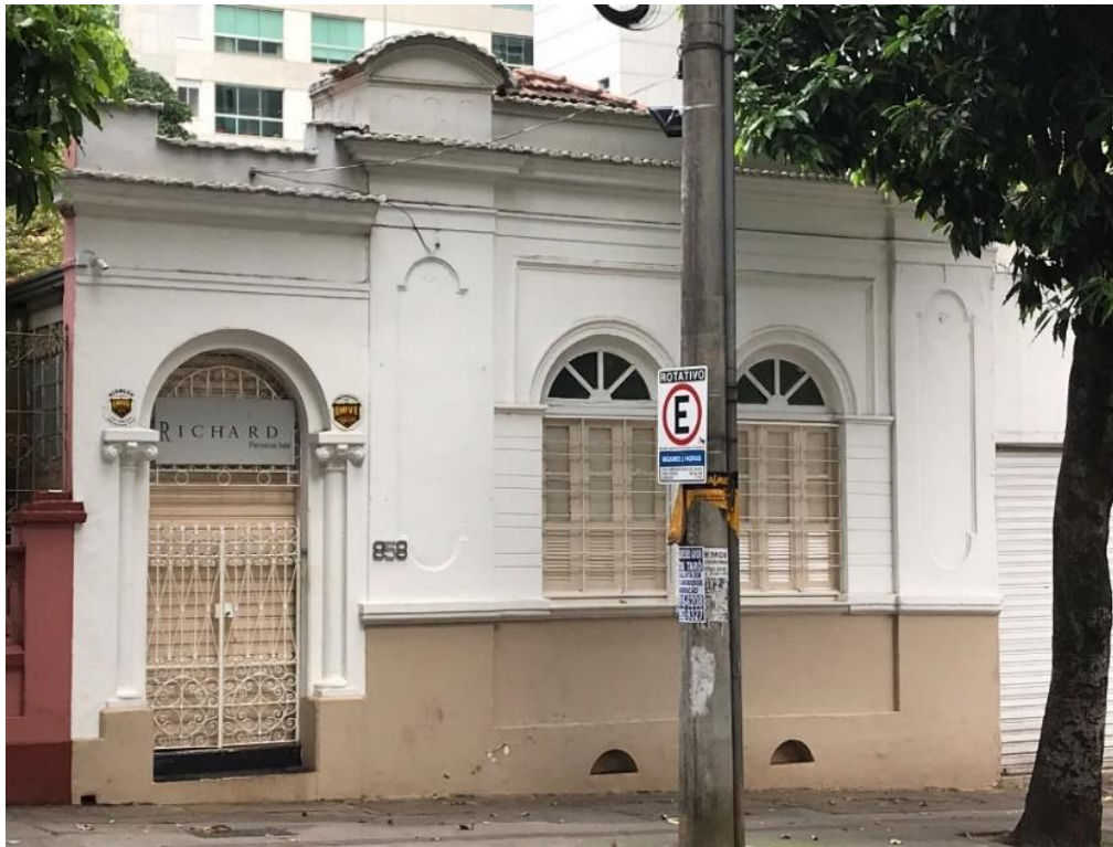
Figura 53 – Fachada da edificação da Rua Paraíba
