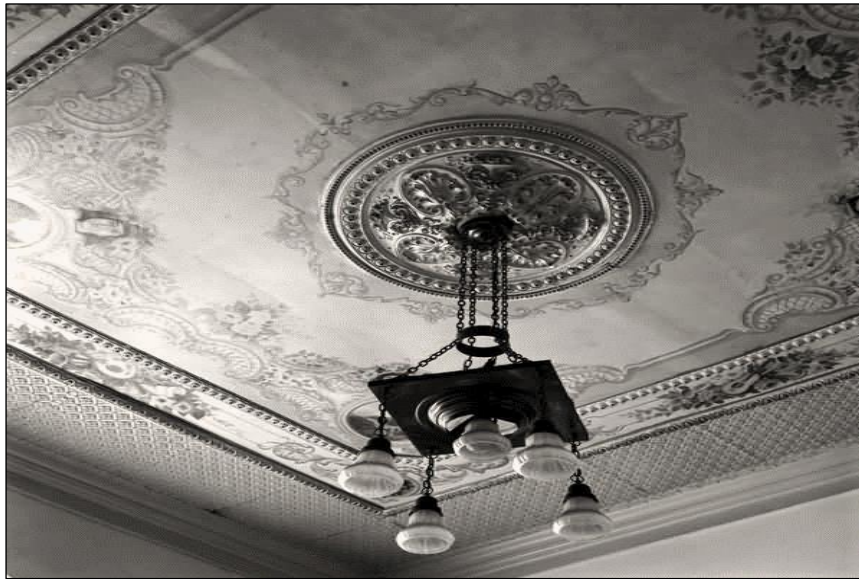
Figura 30 – Forro decorativo da casa da Rua Santa Rita Durão, 1033
