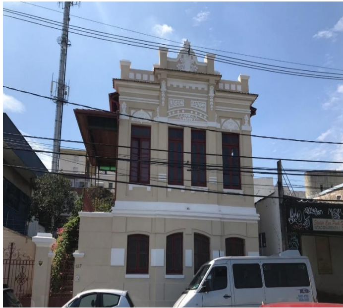
Figura 78 – Fachada da edificação
