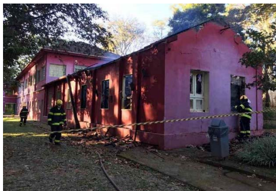
FIGURA 71 - Vista lateral da edificação incendiada.
