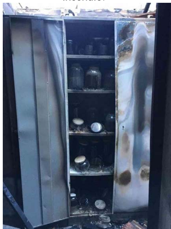
FIGURA 80 - Mobiliário em aço da Sala C, com acervo da zoologia destruído pelo incêndio.
