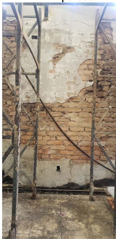
FIGURA 75 - Sala A: ausência de fuligem na parede.
