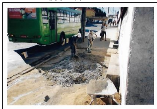
FIGURA 63 - TRABALHO NA CALÇADA DA ESCOLA. SEM DATA
