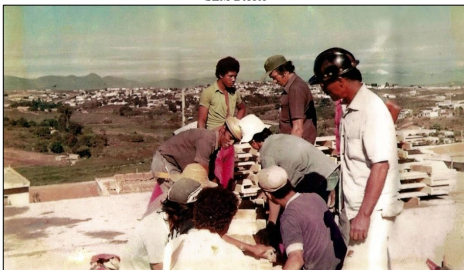
FIGURA 55 - IGREJA JESUS RESSUSCITADO EM CONSTRUÇÃO. SEM DATA
