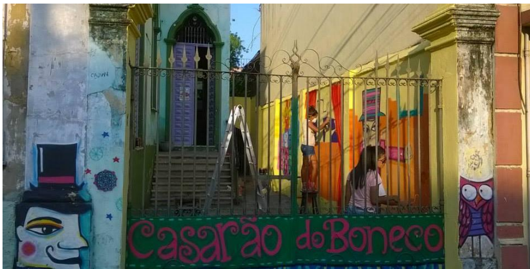
Figura 86: Fachada do Casarão do Boneco.
