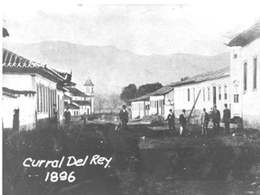
Figura 4 – Obras da Construção de Belo Horizonte - 1896
