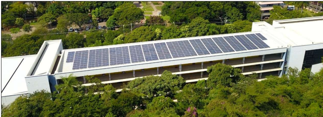
Figura 17 - Foto aérea da usina fotovoltaica dos prédios do CAD, na UFMG
