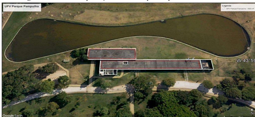
Figura 35 - Local de implantação da UFV Parque Pampulha com área de 800 m 2
