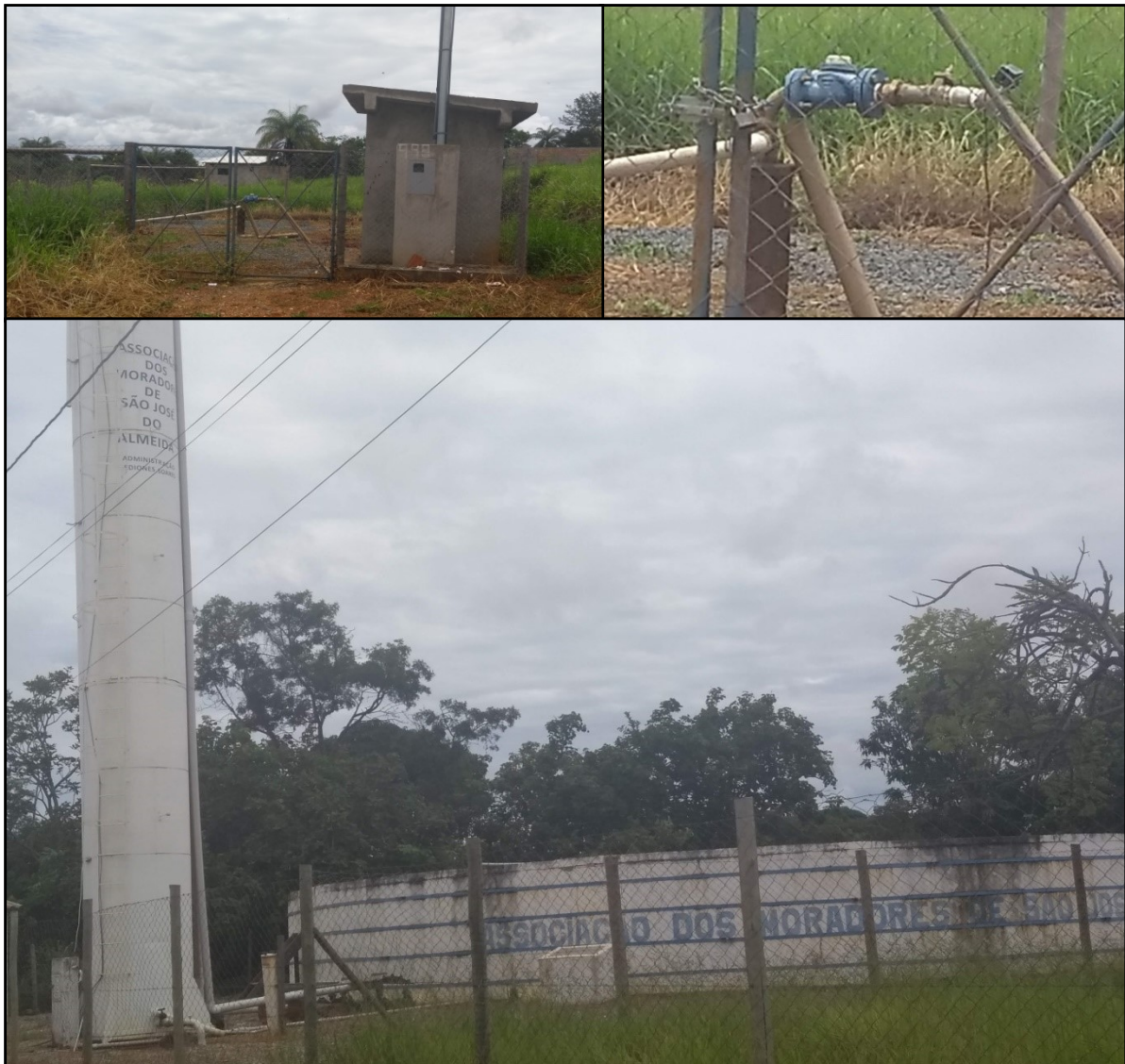
FIGURA 4.3: Poço e reservatórios pertencentes ao sistema de abastecimento de água de São José do Almeida
