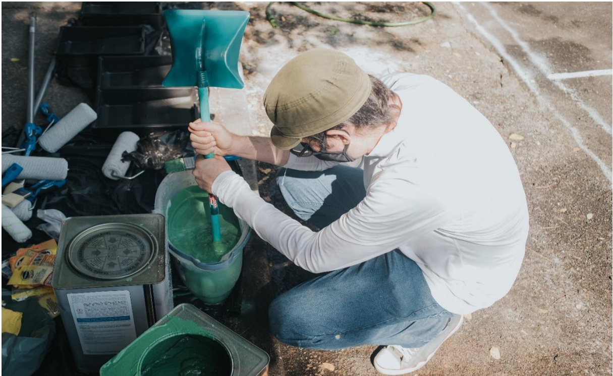
Figura 116 - Início da instalação da intervenção na área da rua incorporada à praça
