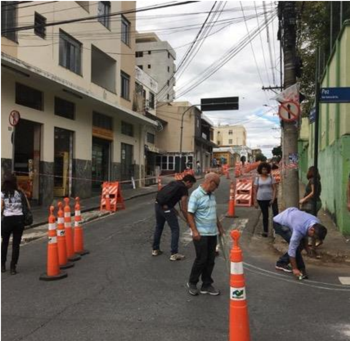
Figura 34 - Rua Simão Tamm. Primeiro dia de montagem da intervenção
