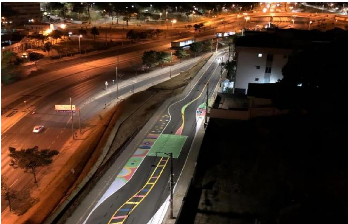
Figura 87 - Projeto Zona 30 Diamantina concluído
