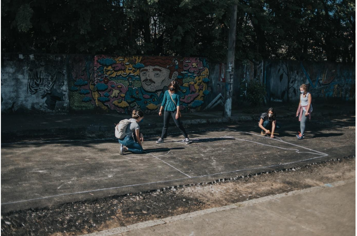
Figura 114 - Início da demarcação do projeto na rua
