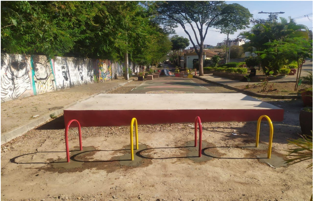
Figura 131 - Instalação dos paraciclos
