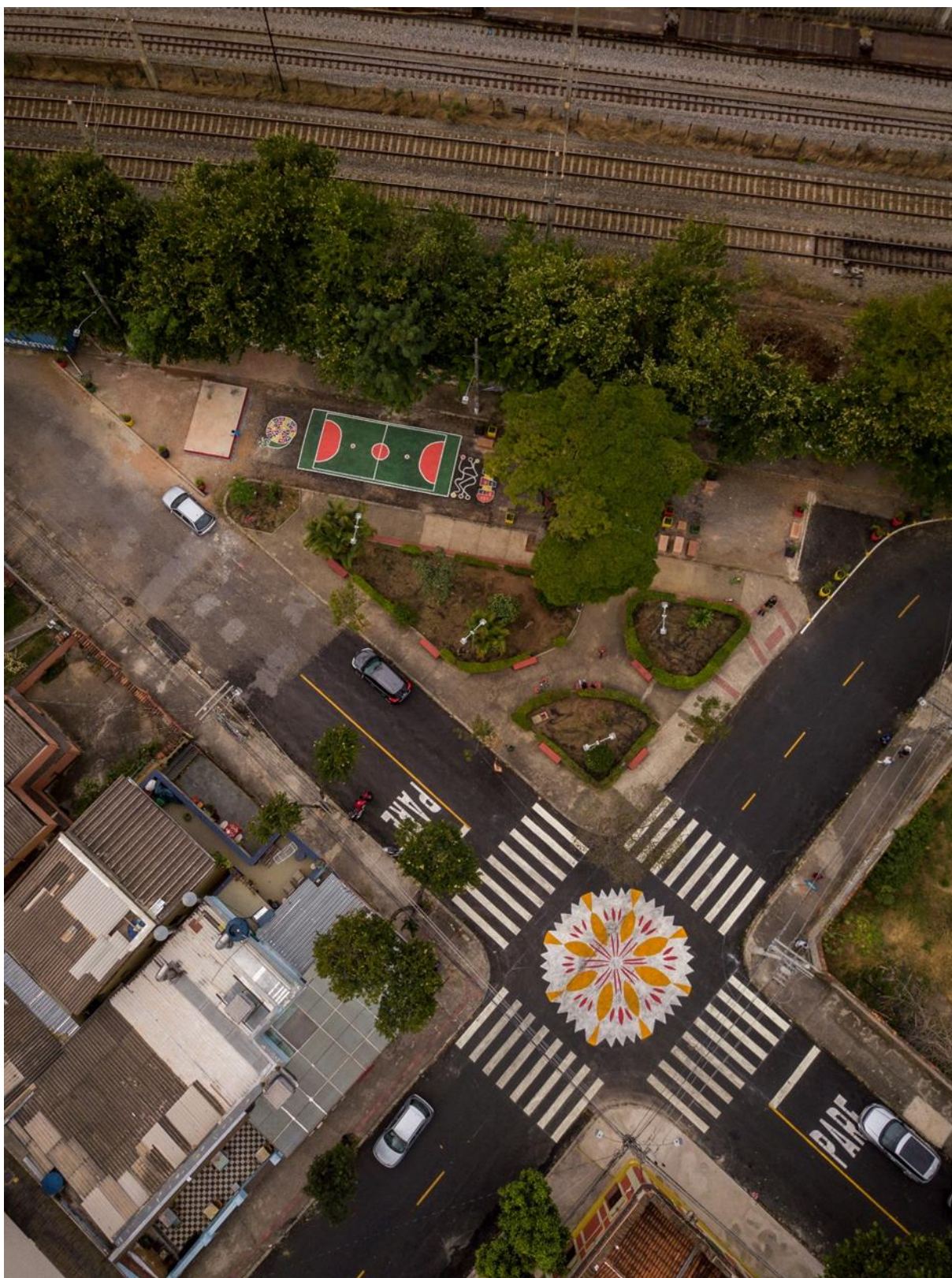
Figura 125 - Área depois da intervenção implantada
