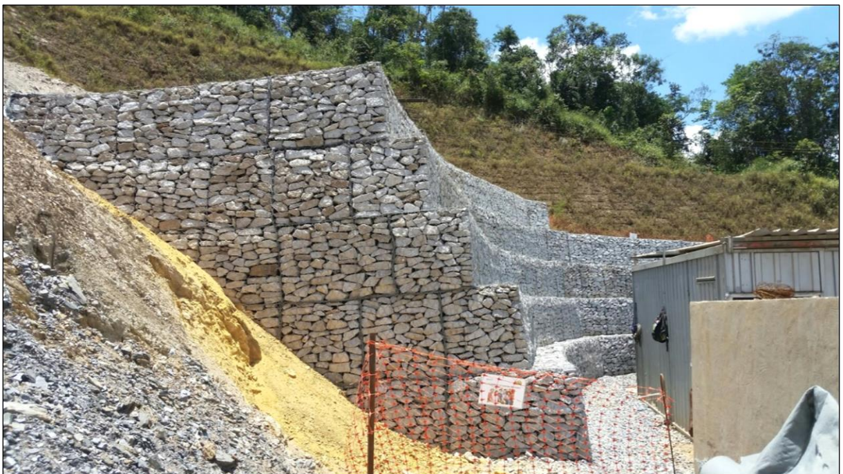
Figura 6: Muro de gabião já executado
