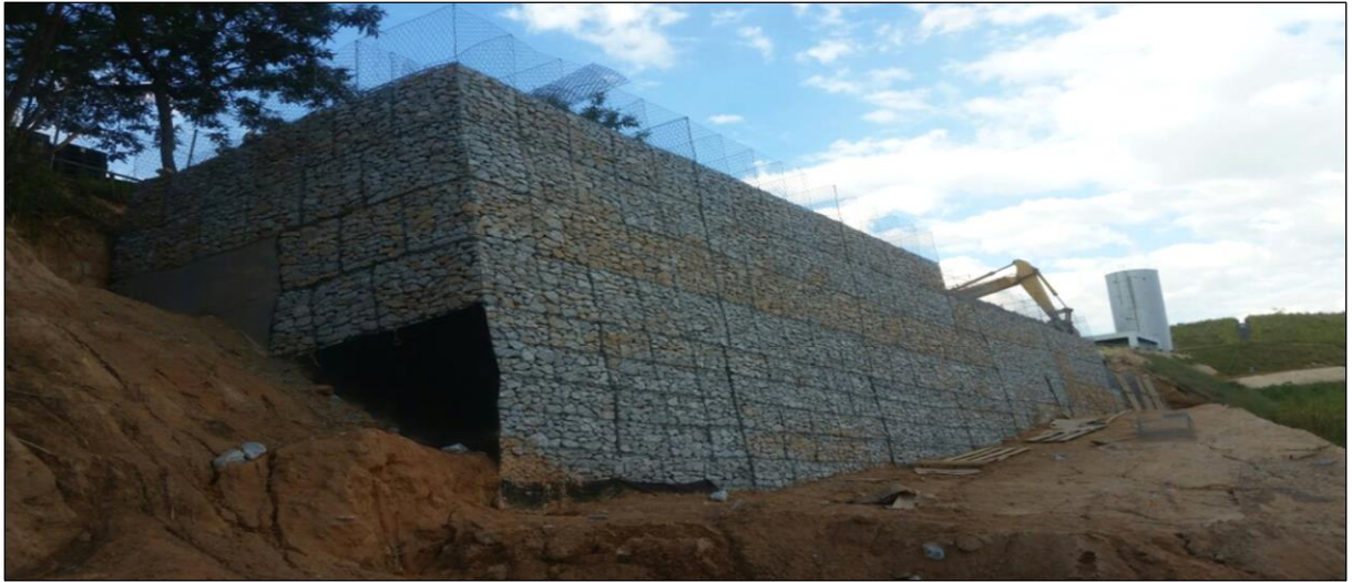
Figura 5: Muro de gabião já executado
