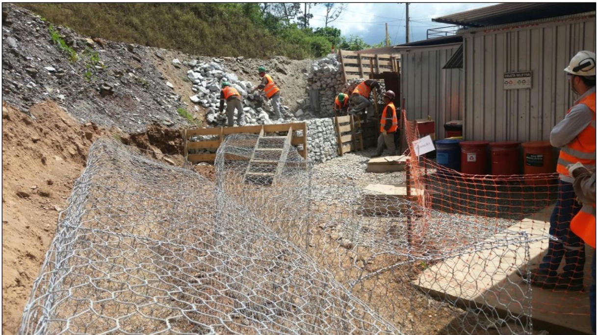
Figura 7: Posição do trabalho na montagem de gabião
