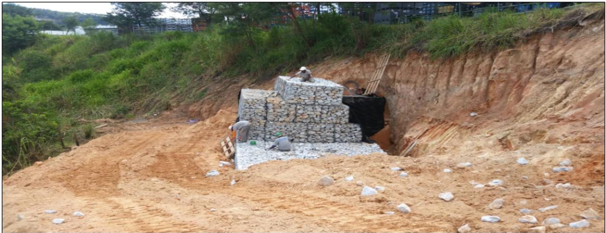
Figura 4: Enchimento do gabião caixa
