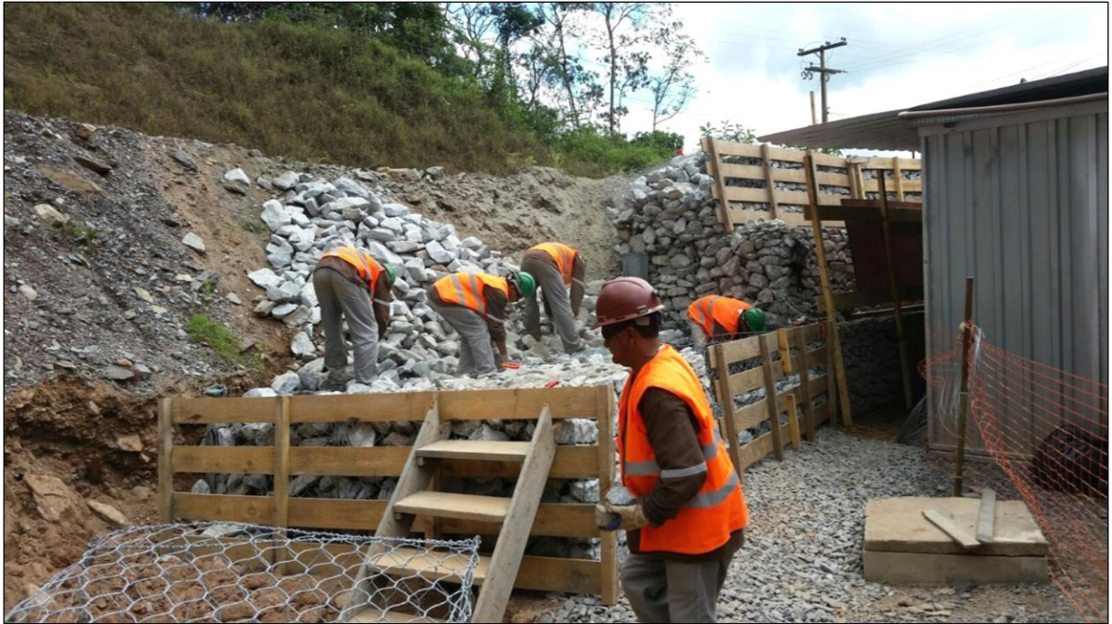
Figura 8: Posição do trabalho na montagem de gabião
