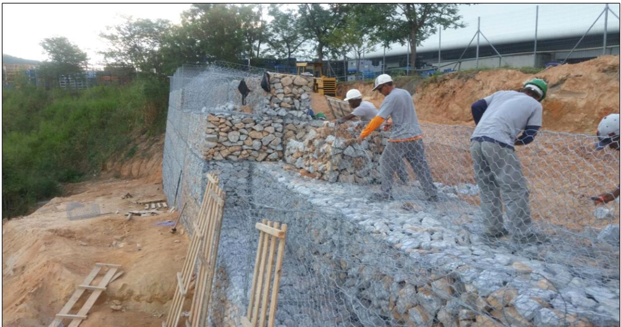
Figura 3: Colocação de gabarito de madeira
