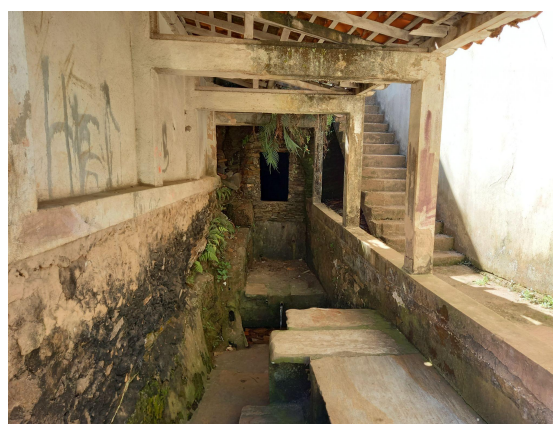
Foto 24: Detalhe de uma mina de água que se localiza na lateral coberta de uma edificação colonial.
