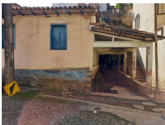
Foto 23: Vista de mina de água que se localiza na lateral coberta de uma edificação colonial na Rua Santa Rita.
