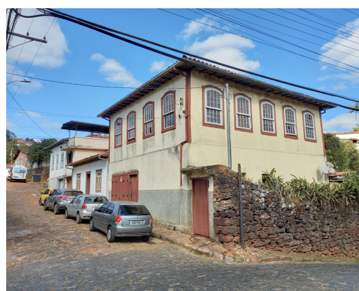
Foto 20: Edificação na Rua Rezende que pode ser observada no registro histórico, apresentando ainda aspectos semelhantes como a sequência de esquadrias da fachada lateral.
