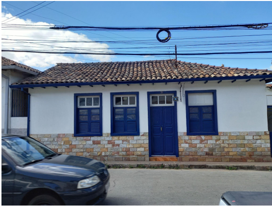
Foto 37: Edificação na Rua Desidério de Matos com meia parede revestida.
