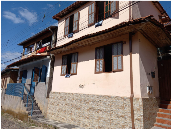
Foto 41: Edificação na Rua Nossa Senhora do Parto, apresentando diferentes modernizações.
