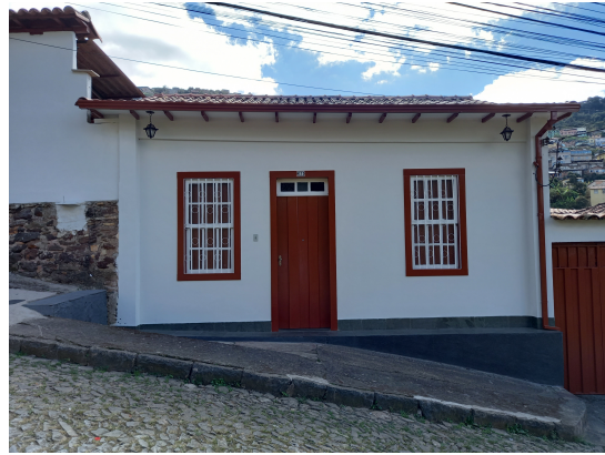
Foto 6: Edificação localizada na Rua Padre Faria, no número 249.
