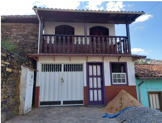
Foto 7: Edificação na Rua Padre Faria com determinadas características do estilo colonial, porém com presença de "inovações".
