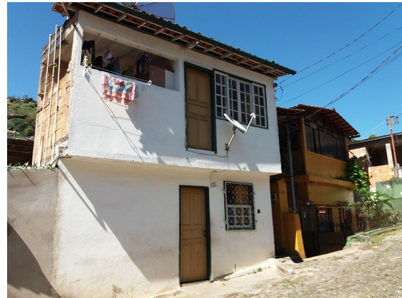
Foto 44: Edificação informal na Rua Oito de Setembro em que elementos como a janela em guilhotina são inseridos.
