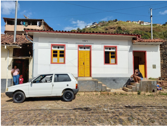
Foto 5: Edificação construída em 1937, de acordo com inscrição na fachada, e inventariada pela Prefeitura Municipal. Localizada na Rua Padre Faria.
