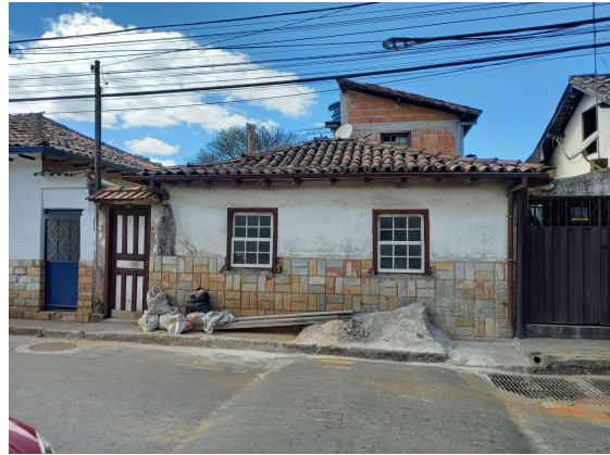
Foto 38: Edificação na Rua Desidério de Matos, além das modificações nas fachadas observa-se acréscimo em trecho posterior.
