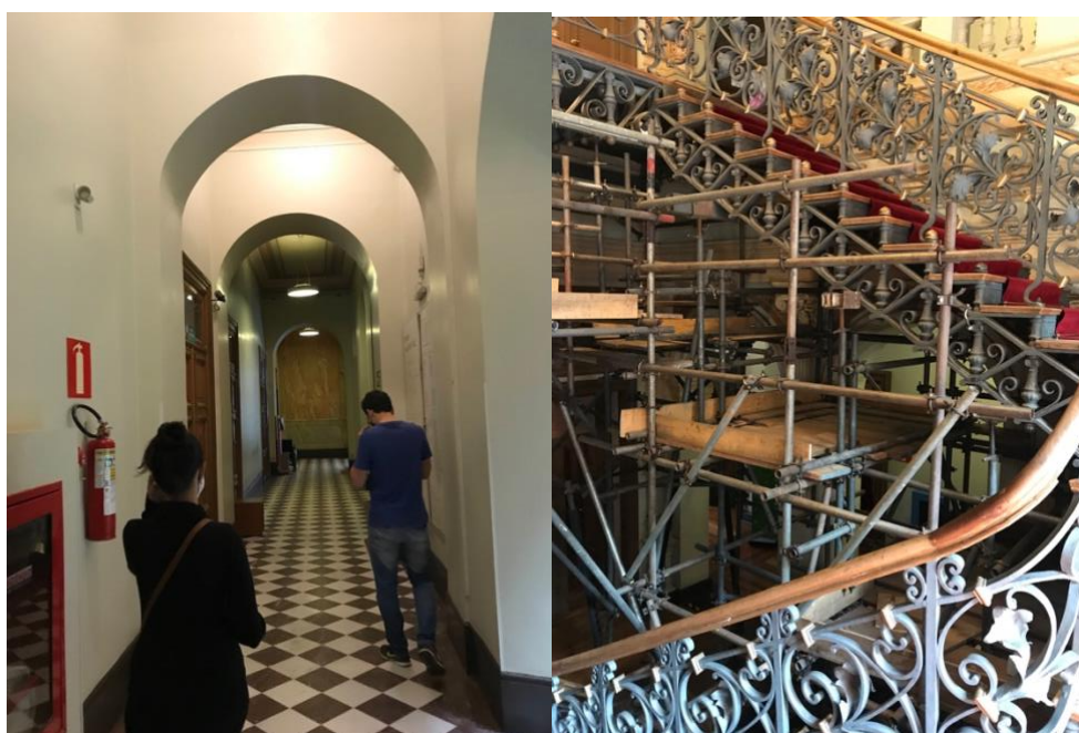
Figura 34 - Visita inicial realizada em novembro de 2020 na presença de um funcionário do museu e outra pesquisadora (à esquerda); Trechos dos andaimes da restauração da escadaria principal (à
