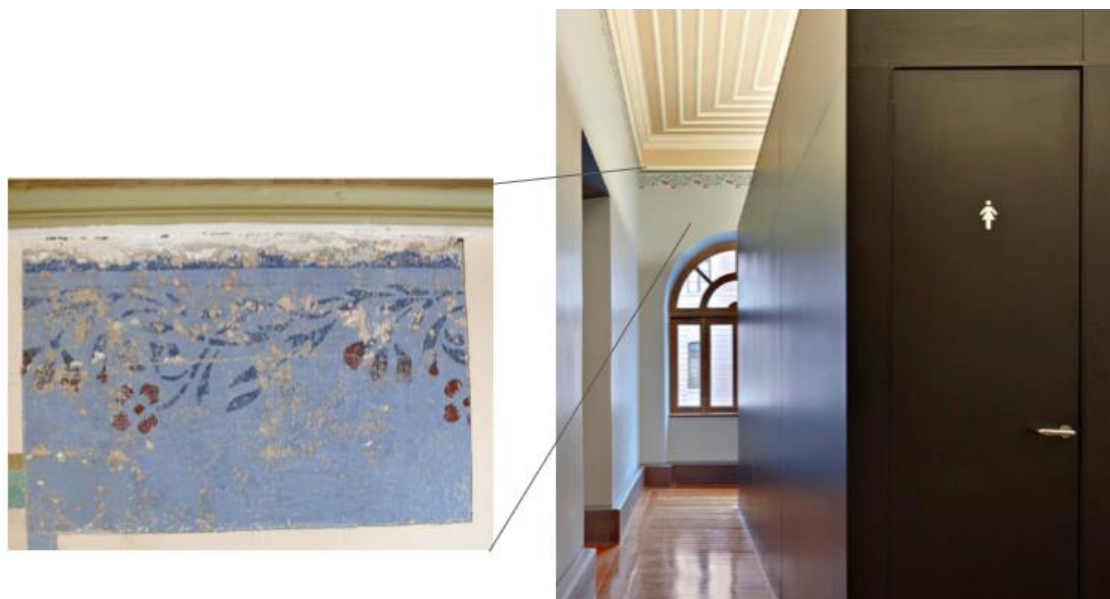
Figura 33 - Sala ocupada por volume com sanitários novos. Ainda assim, as pinturas antigas foram recuperadas. À esquerda, imagem de parte das pinturas parietais que preenchem a maioria dos ambientes.
