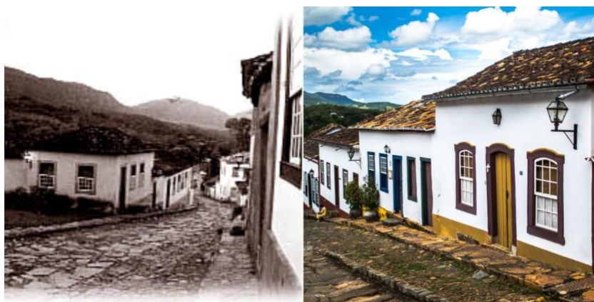
Figura 11 - Centro antigo de Tiradentes (à esquerda); centro antigo de Tiradentes depois das obras de preservação, já no século XXI (à direita). Disponível em < https://bit.ly/2QSIQ8V > e < https://bit.ly/3dsRNiK > - Acesso em 27 de março de 2020.
