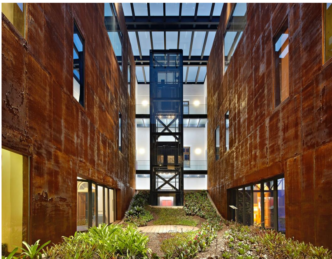
Figura 49 - Pátio interno. Imagem registrada antes do início da presente pesquisa. Disponível em: < https://bit.ly/387cdwo > - Acesso em 23 de agosto de 2021.
