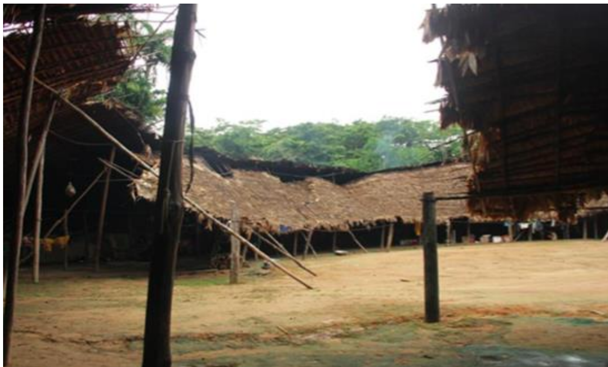
Figura 6. Visão interna do shabono da comunidade de Taibrapa-I, onde pode-se observar as estruturas em palha e madeira, assim como a ausência de repartições internas. Fonte: SÁNCHEZ-RIBAS, 2015.
