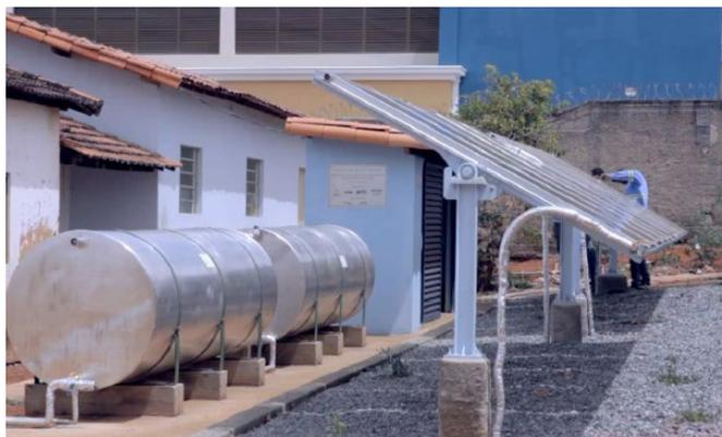
Figura 25 – Trocadores de calor acoplados aos módulos fotovoltaicos Vila Vicentina
