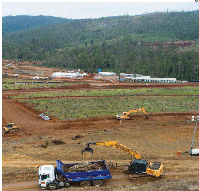
Figura 2– Local e início das obras do Novo distrito de Bento Rodrigues
