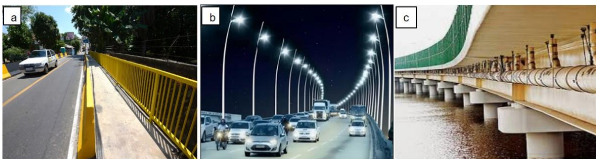
Figura 3 – (a) Faixas para pedestre, (b) Iluminação na ponte (c) sistema de drenagem Fonte: Semcom (2017), DPF (2013), Hobas, (2019).
