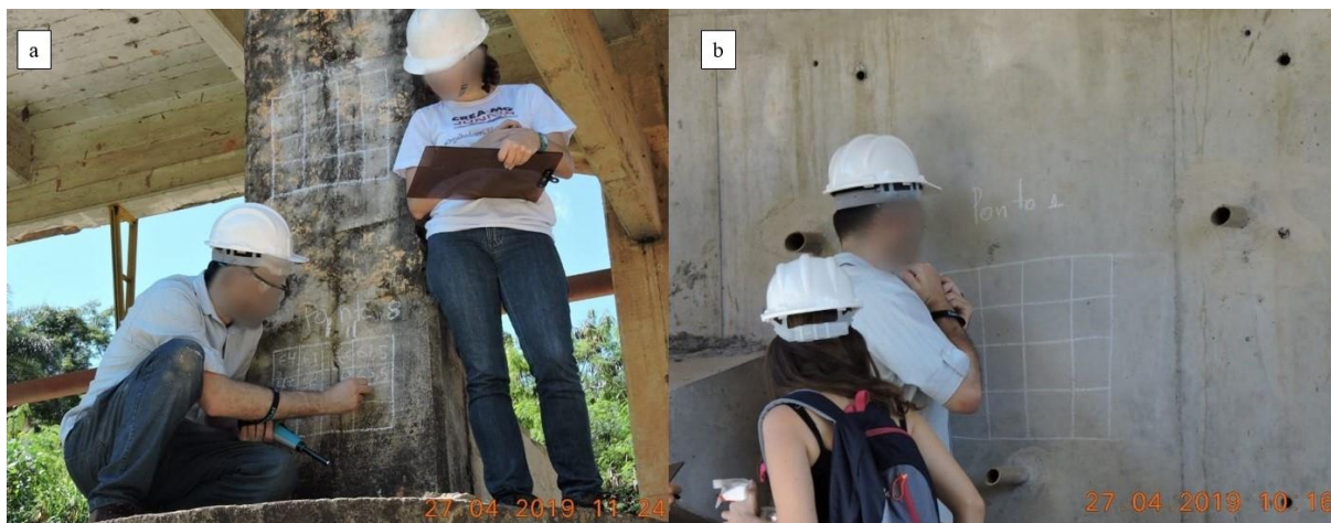
Figura 35- OBRA/B, Pilar no Rio PR6 (a) e Cortina 9C (b)
