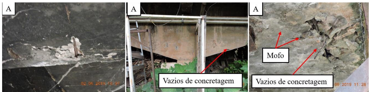
Figura 27-Cobrimento das armaduras nas OAE – A
