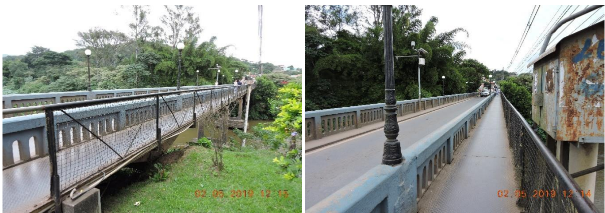
Figura 13- Ponte sobre o rio das velhas rodovias Municipal trecho Rio Acima (2019)
