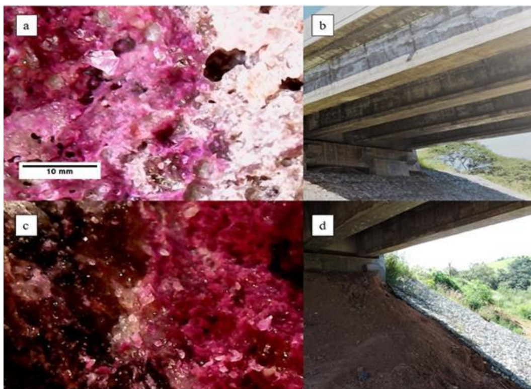
Figura 25- Bloco de fundação cortina da obra C, (a) foto da lupa, (b) foto normal, Viga de ligação, (c) foto da lupa, (d) foto normal.
