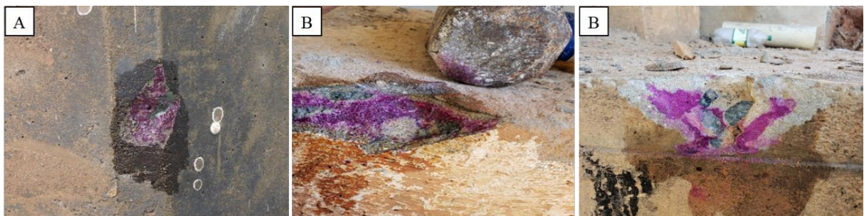
Figura 26- Ensaio de carbonatação nas OAEs
