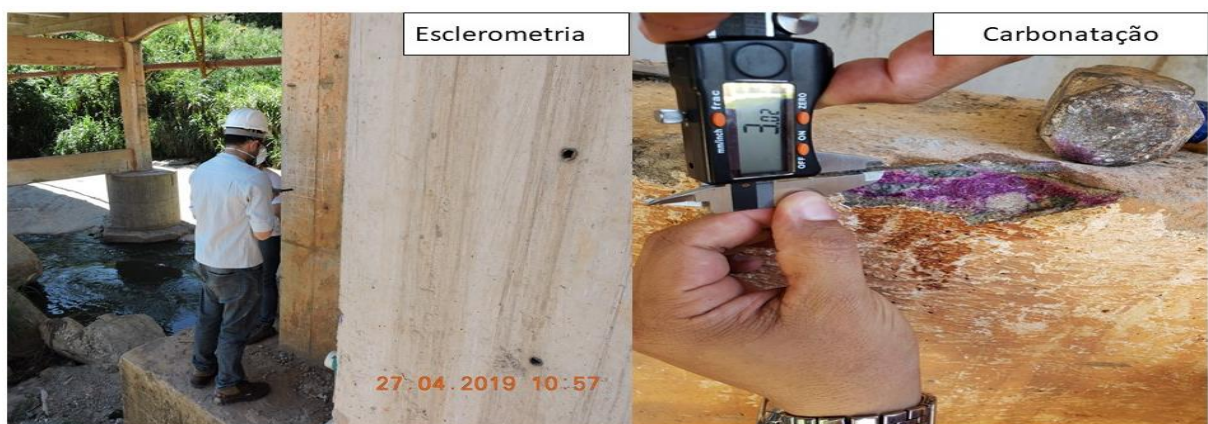
Figura 18- Ensaios Realizados Esclerometria, e Carbonatação.
