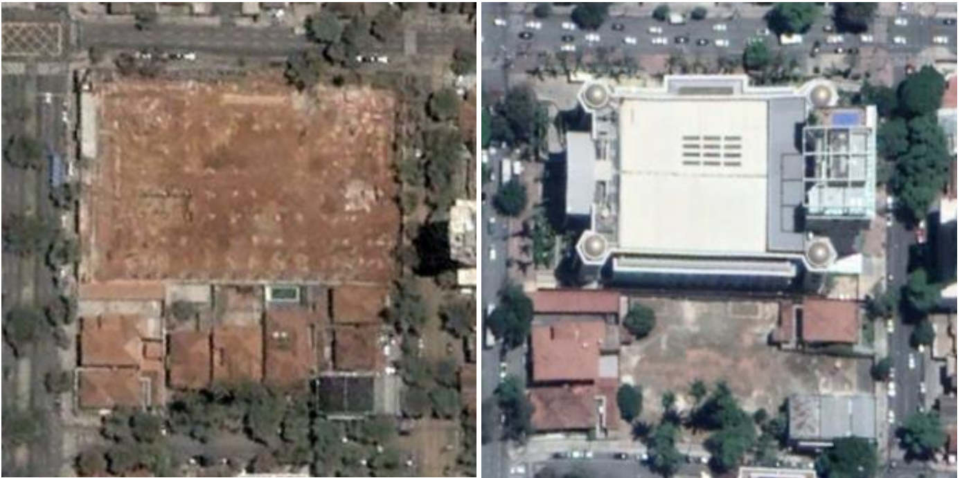
Figura 28 – À esquerda, quarteirão onde seria construída a Catedral da Fé em 27/11/2002, à direita, o mesmo local, 15 anos depois, com as casas demolidas.
