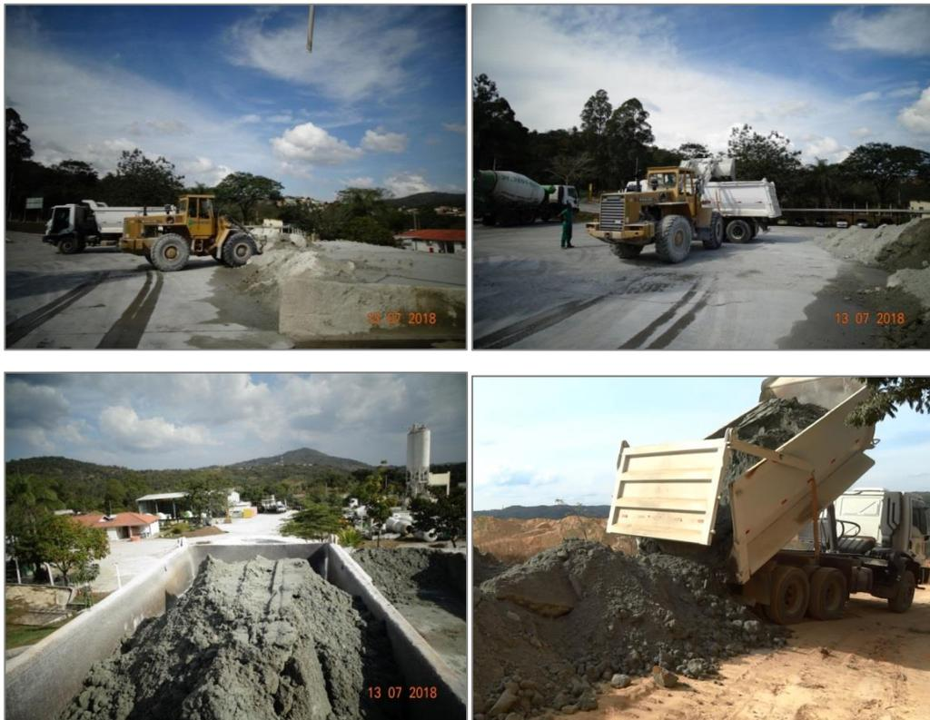
Figura 3.3 - Carga, transporte e descarga do RCFL
