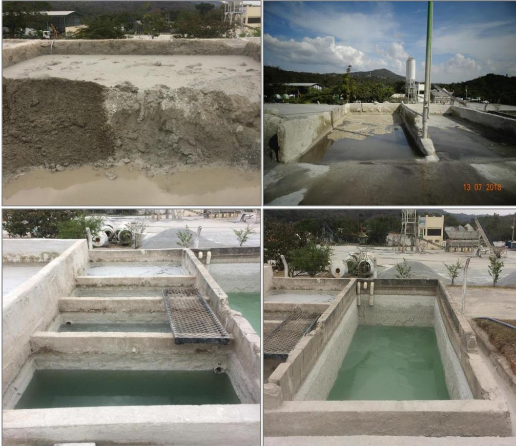
Figura 3.2 - Conjunto de caixas de decantação de resíduos úmidos da usina de concreto
