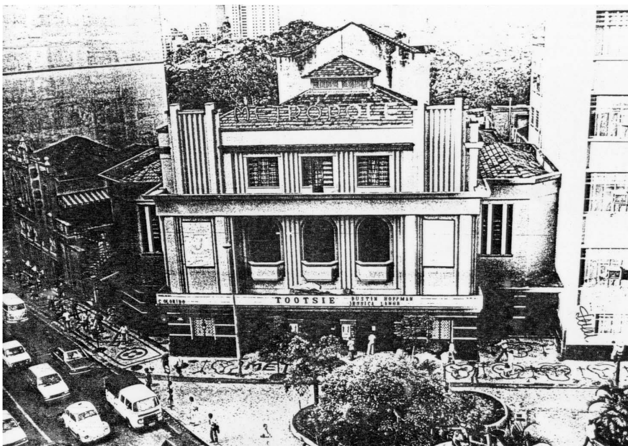
Figura 24: Sem autoria. Cine Metr pole, 1983. Fotografia.
