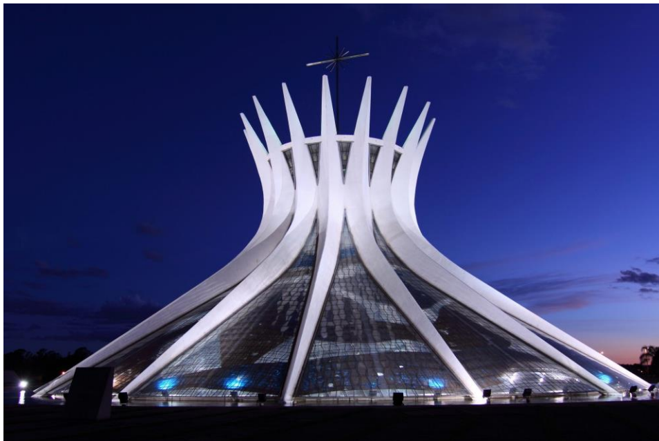
Figura 20: Catedral de Brasília com suas colunas externas em forma de parábolas. Fonte: https://www.segueviagem.com.br/geral/obras-de-oscar-niemeyer-em-brasilia/
