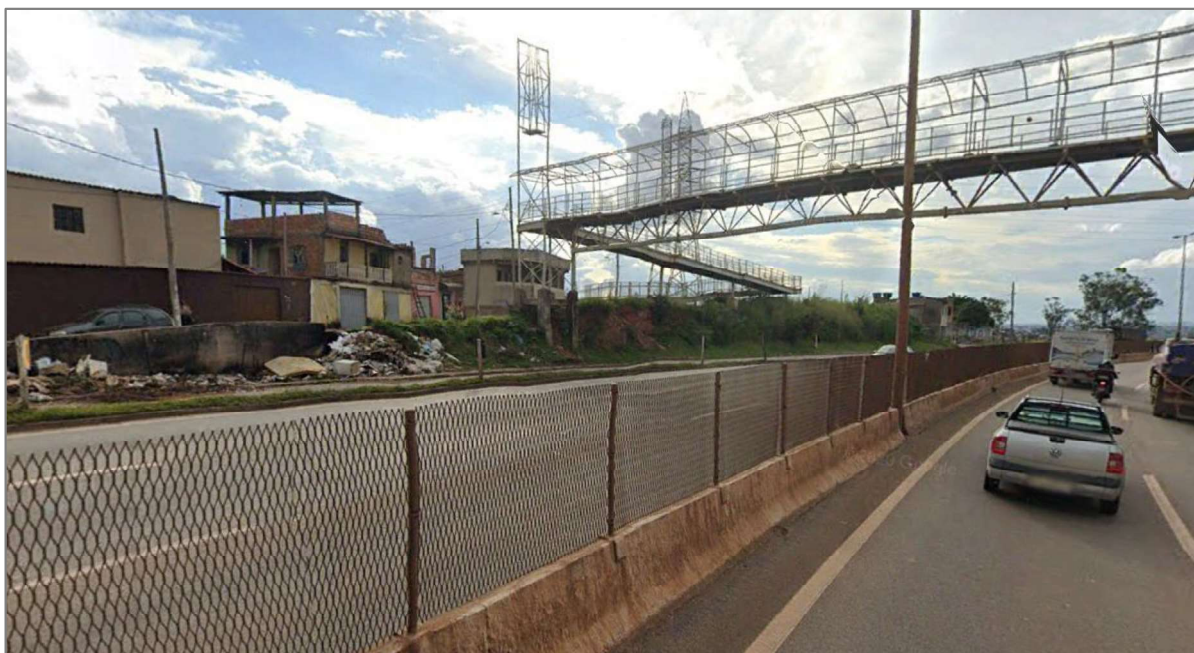
Figura 5.30: Gradis de segregação de pistas utilizados nas proximidades das passarelas instalados entre o Subtrechos 1A e 2 do Anel Rodoviário Celso Mello Azevedo.
