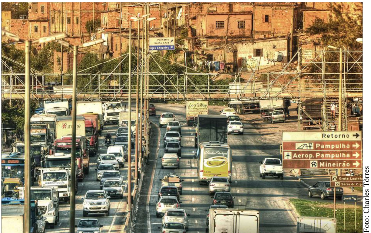
Figura 3.8: Ocupações irregulares às margens do Anel Rodoviário na altura do Viaduto São Francisco (Av. Presidente Antônio Carlos).
