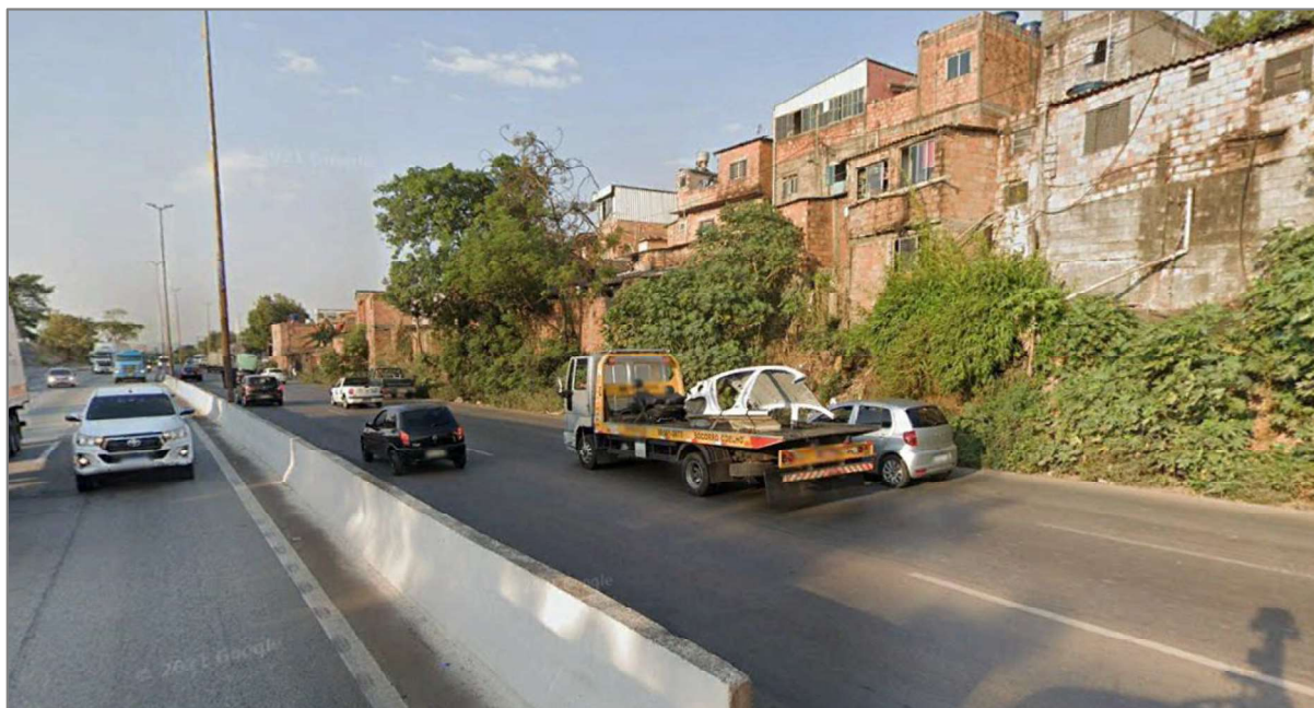
Figura 5.29: Segregação das pistas do Anel Rodoviário Celso Mello Azevedo realizada por dispositivos do tipo New Jersey.
