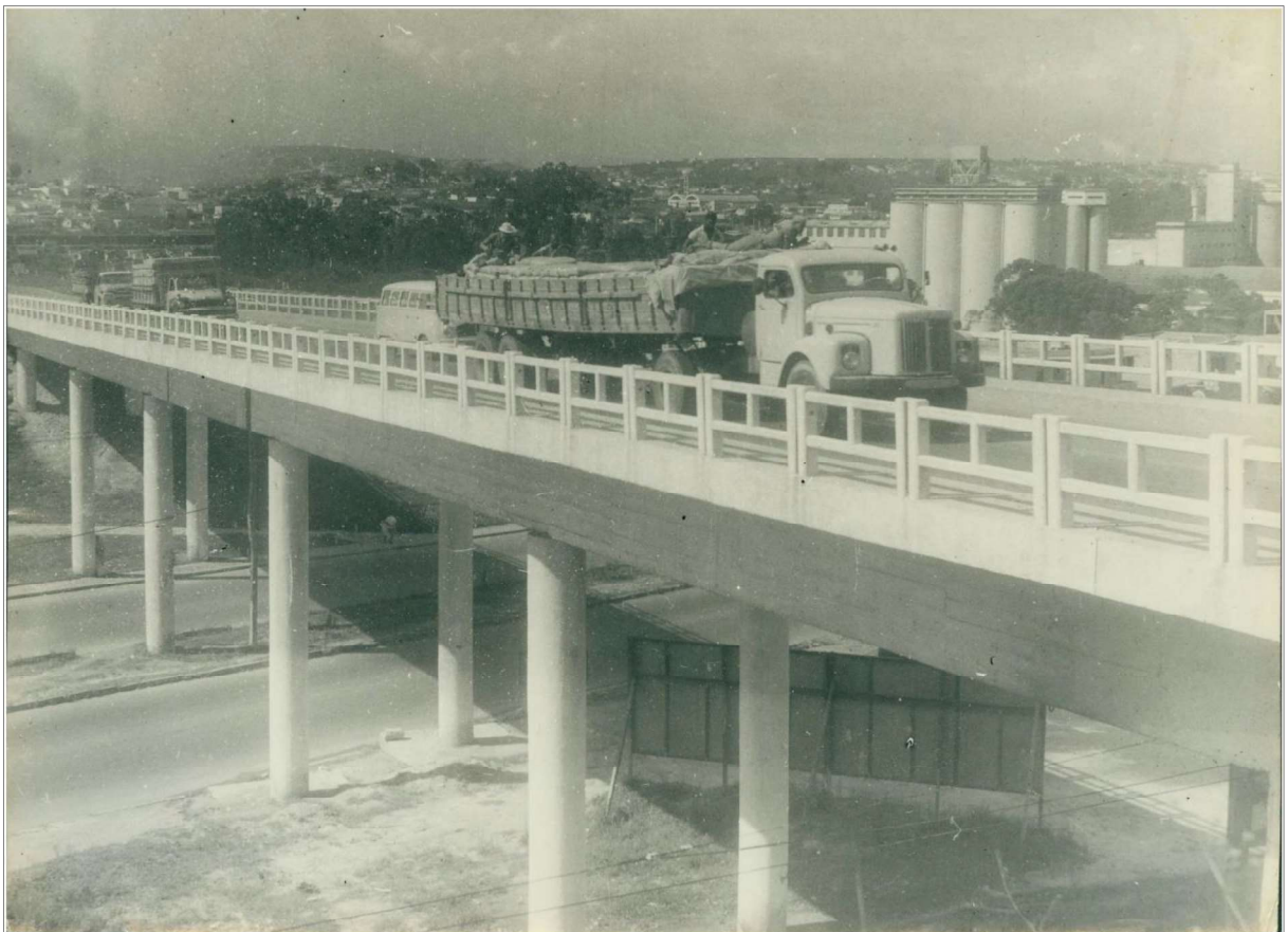
Figura 3.3: Vista do viaduto do Anel Rodoviário de Belo Horizonte sobre a Avenida Amazonas, com a Cidade Industrial ao fundo.
