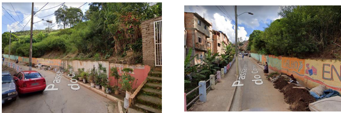
Figura 48 – Rua Engenheiro Caetano Lopes com asfaltamento implantado e sem a presença de entrada para residências (2019)
