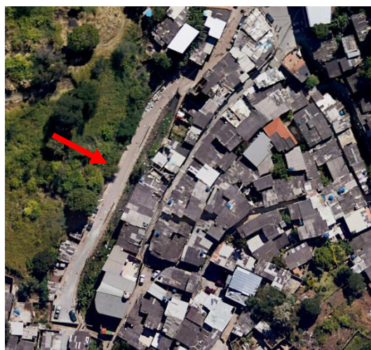
Figura 47 – Rua Engenheiro Caetano Lopes após a execução das obras, nota-se que o asfaltamento já havia sido implementado no local
