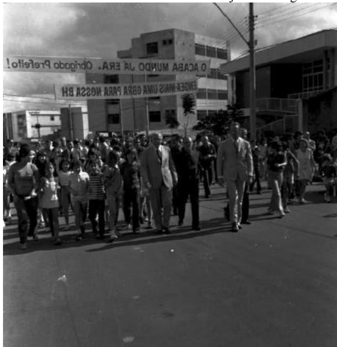
Figura 33 - Inauguração do asfalto da Av. Uruguai, julho de 1973. Moradores dos bairros Carmo e Sion estenderam faixas onde se lê: “O Acaba Mundo já era. Obrigado Prefeito!”
