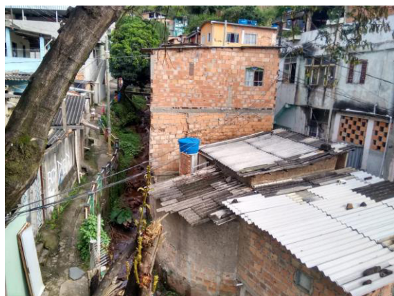
Figura 23 - Residências na Vila Acaba Mundo, vista da Rua Desengano
