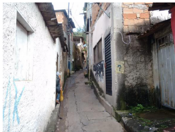
Figura 24 - Residências na Vila Acaba Mundo, vista do Beco São João
