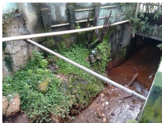
Figura 35 – Córrego Acaba Mundo em canal aberto. À direita, a entrada para o canal revestido fechado
