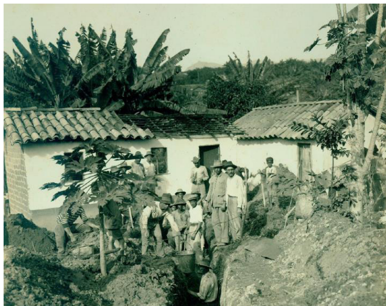
Figura 18 - Construção da rede de esgotos do Barro Preto, 1929
