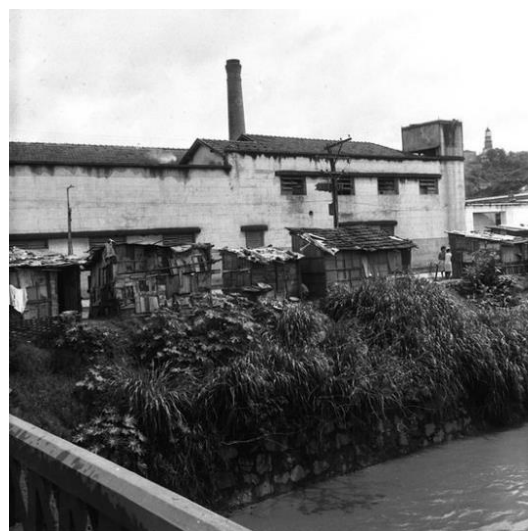
Figura 22 - Barracos às margens do Ribeirão Arrudas no bairro Carlos Prates, Avenida Tereza Cristina. Provavelmente faziam parte da favela Buraco do Peru
