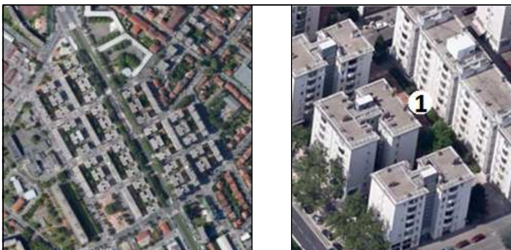
Figura 29 - Vista atual do bairro États-Unis de Tony Garnier, Lyon.
