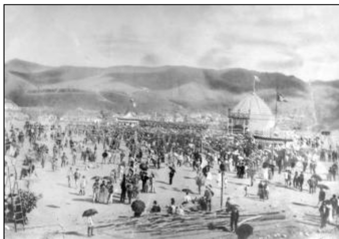
Vista da praça da estação; ao fundo a Serra do Curral.
