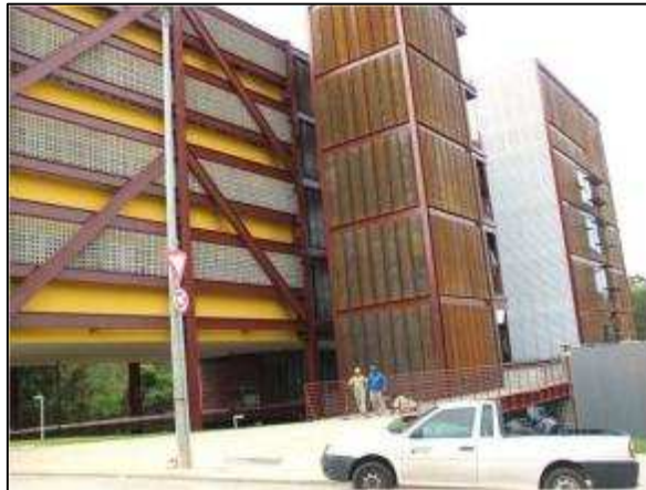
Figura 112 - Prédio em construção em 2010, denominado Centro Administrativo
