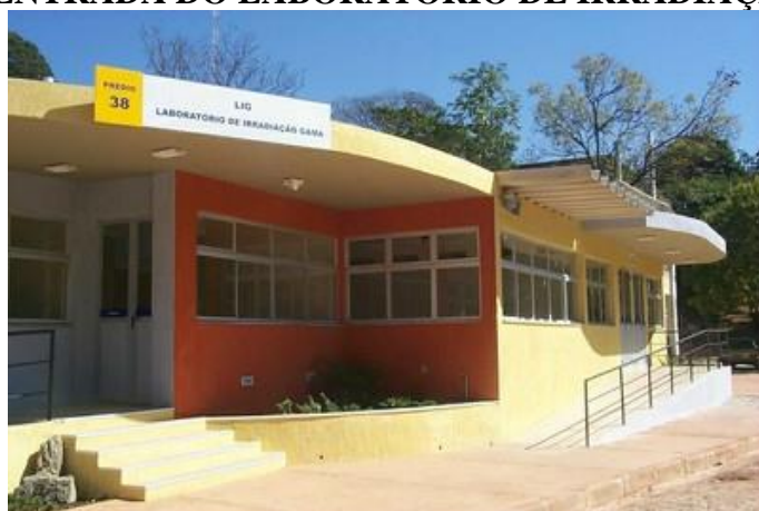
FIGURA 9 – ENTRADA DO LABORATÓRIO DE IRRADIAÇÃO GAMA
