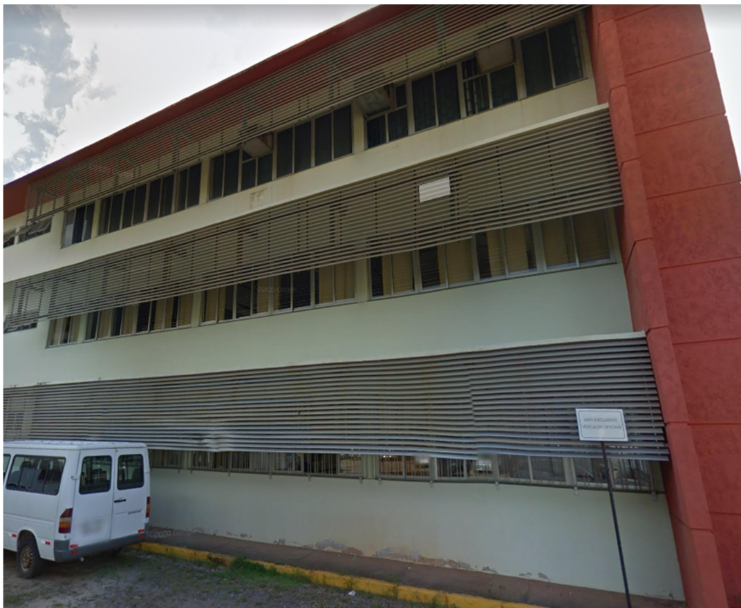
Figura 19 – Fachada do anexo do IGC com janelas de correr com brise
