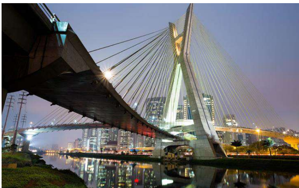
Figura 14: Ponte Octavio Frias de Oliveira (São Paulo). Fonte: Mapa da Obra, 2016.
