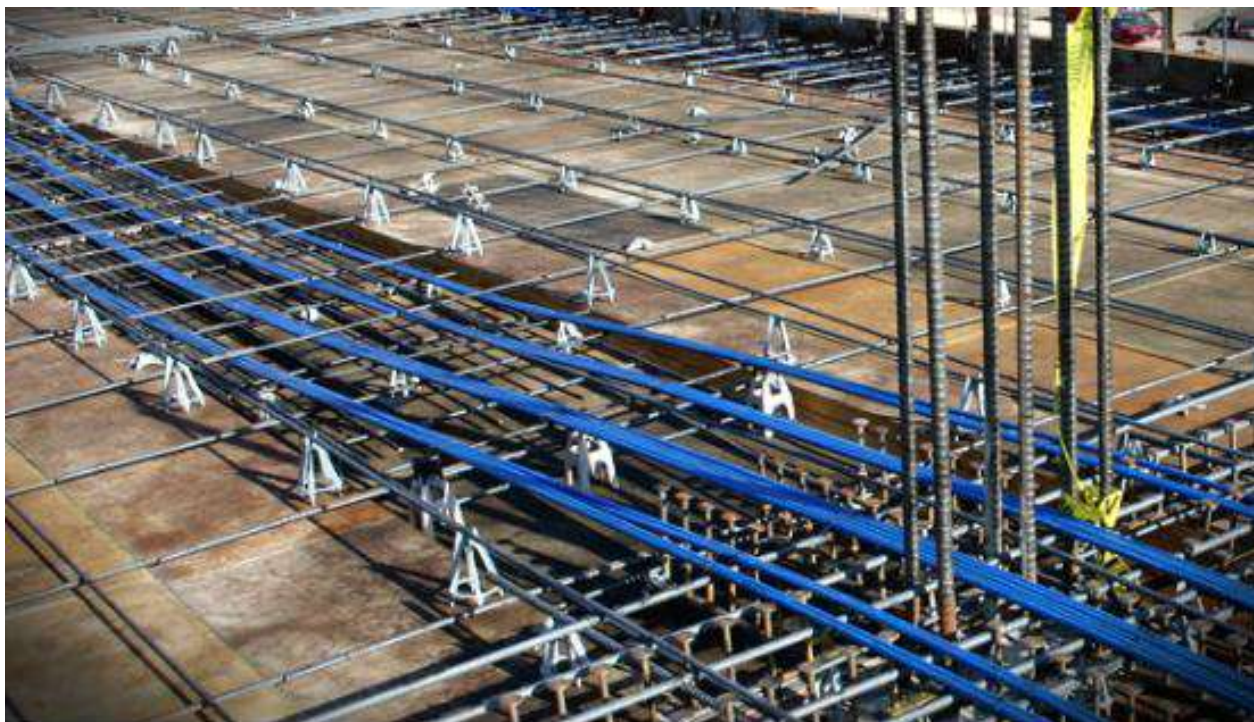
Figura 25: Armadura com cordoalhas Fonte: CAUDURO,2018.
