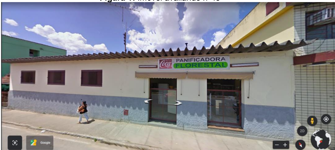
Figura 1: Imóvel avaliando nº49
