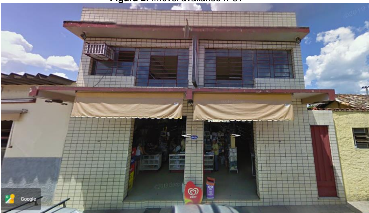
Figura 2: Imóvel avaliando nº61
