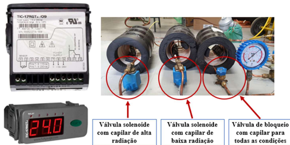
Figura 3.3: Válvulas solenoides, válvula de bloqueio e controlador Full Galge TIC-17RGTi
