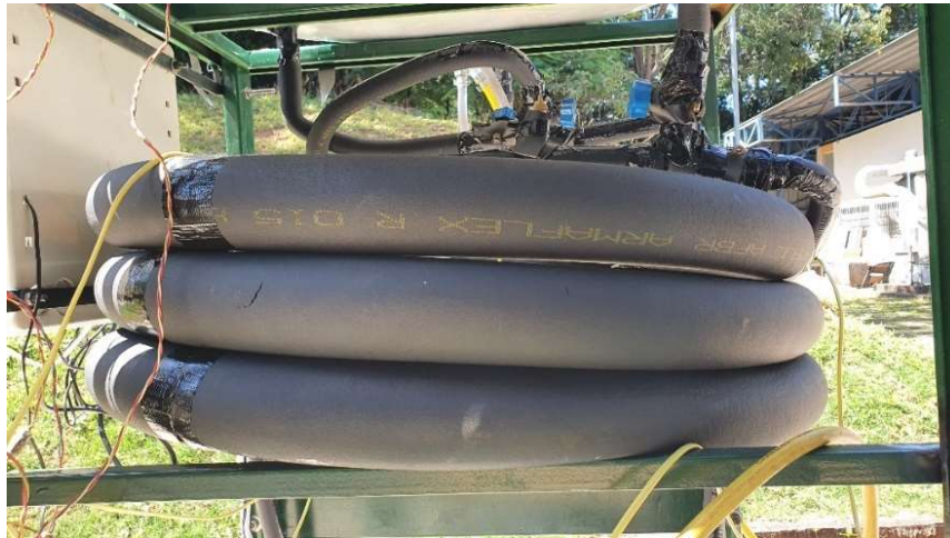
Figura 3.6: Condensador bitubular
