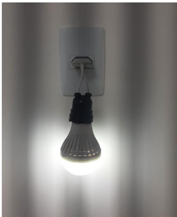
Figura 7 – Dispositivo para teste de funcionamento de tomadas
