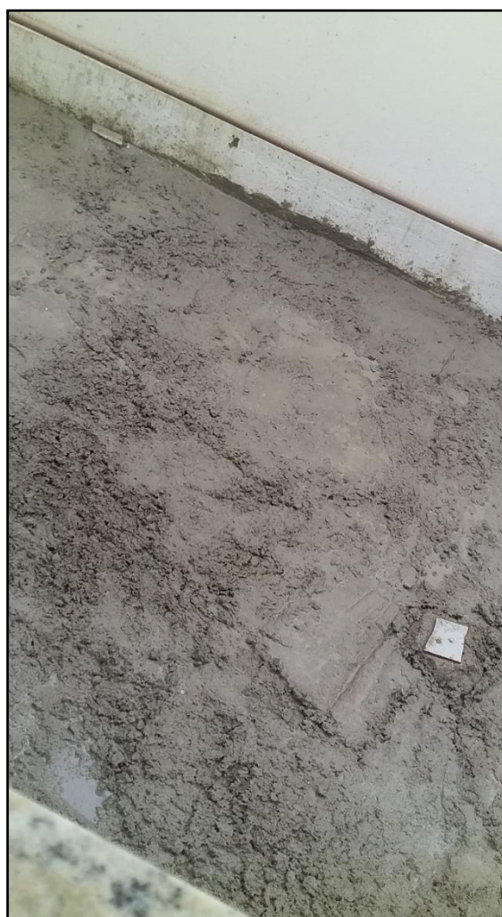
Figura 9 – Execução do contrapiso para assentamento do revestimento cerâmico
