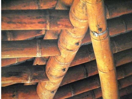
Figura 2.3.10: Uso de parafusos e braçadeira em estruturas com bambu. (VILLEGAS, 2003, p.133).
