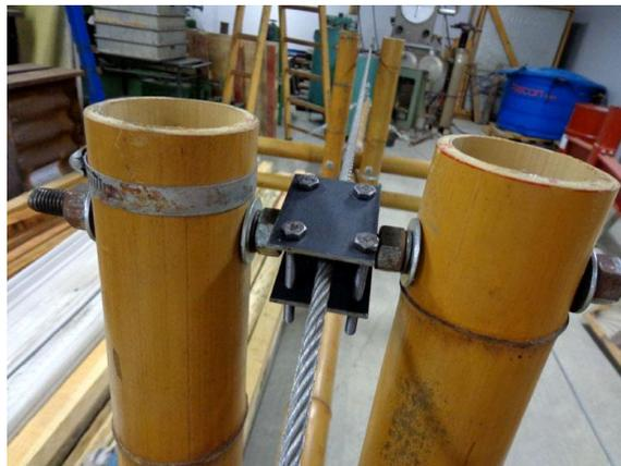
Figura 4.2.53: Vista do clip fixando o cabo de aço no mastro.
