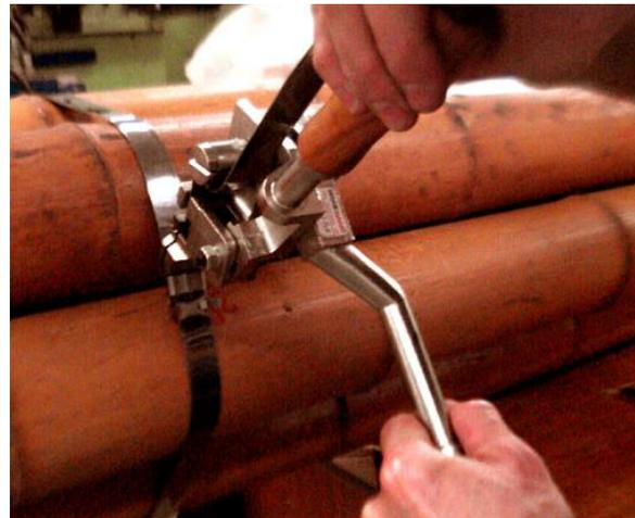
Figura 4.4.5: Tensão e corte da cinta metálica.
