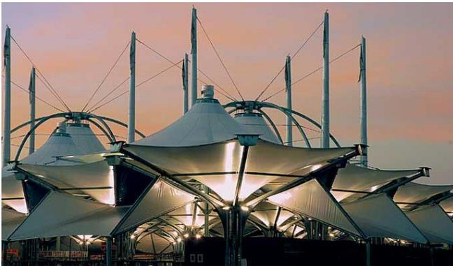
Figura 1.2.8: Estrutura da cobertura tensionada, Feira de Ananindeua, PA. (GELINSKI, 2007)
