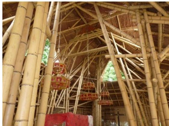
Figura 4.3.29: Detalhe dos elementos compostos parafusados.
