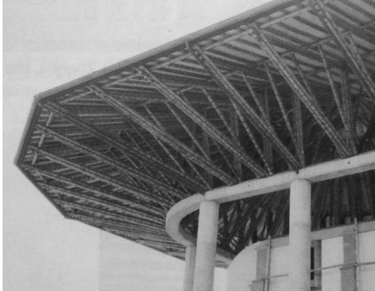
Figura 2.3.14: Feixes de bambu, em coberturas, no Equador. (LOPEZ, 2003, p.386).
