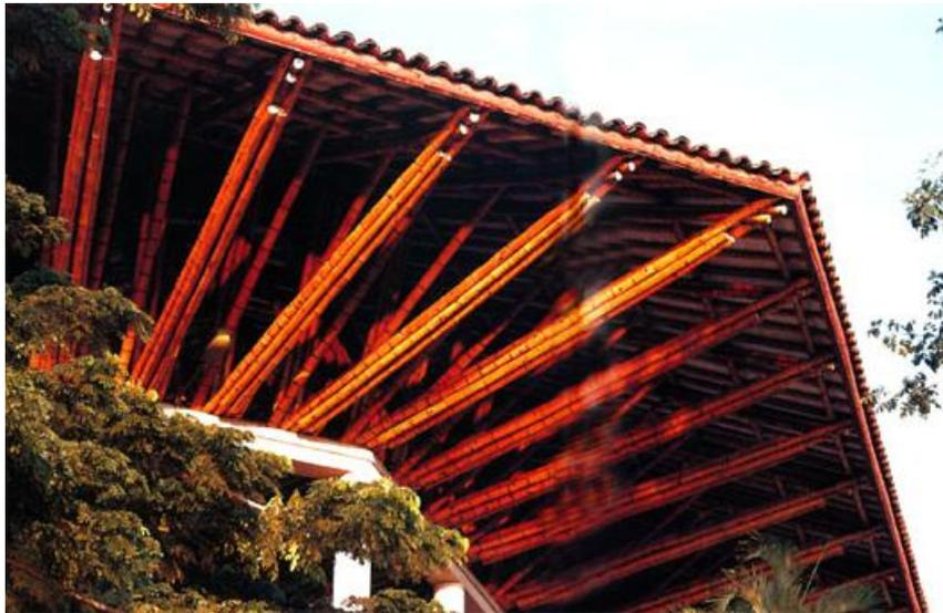
Figura 2.3.5: Estrutura de bambu, na Colômbia. (VILLEGAS, 2003, p.68).
