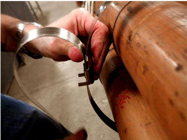
Figura 4.4.4: Instalação da cinta metálica.
