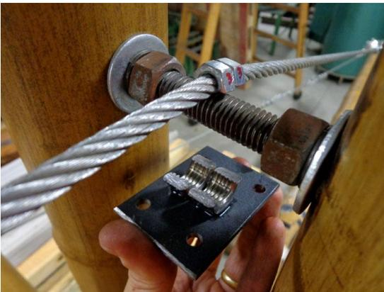
Figura 4.2.51: Instalação do clip no mastro.
