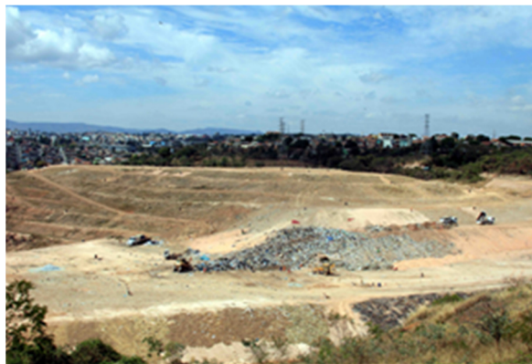
Figura 7: Aterro Sanitário Municipal
