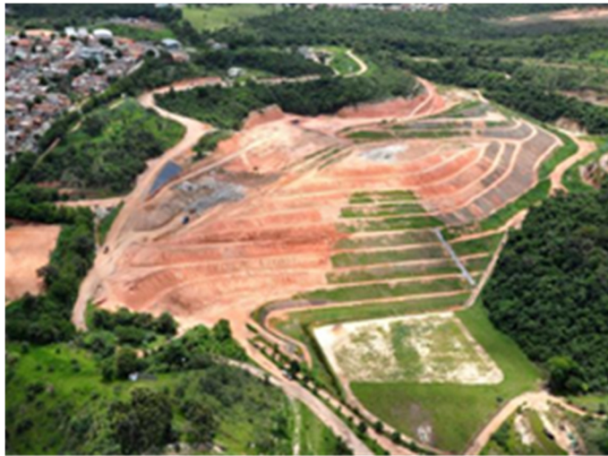
Figura 6: Aterro Sanitário Municipal
