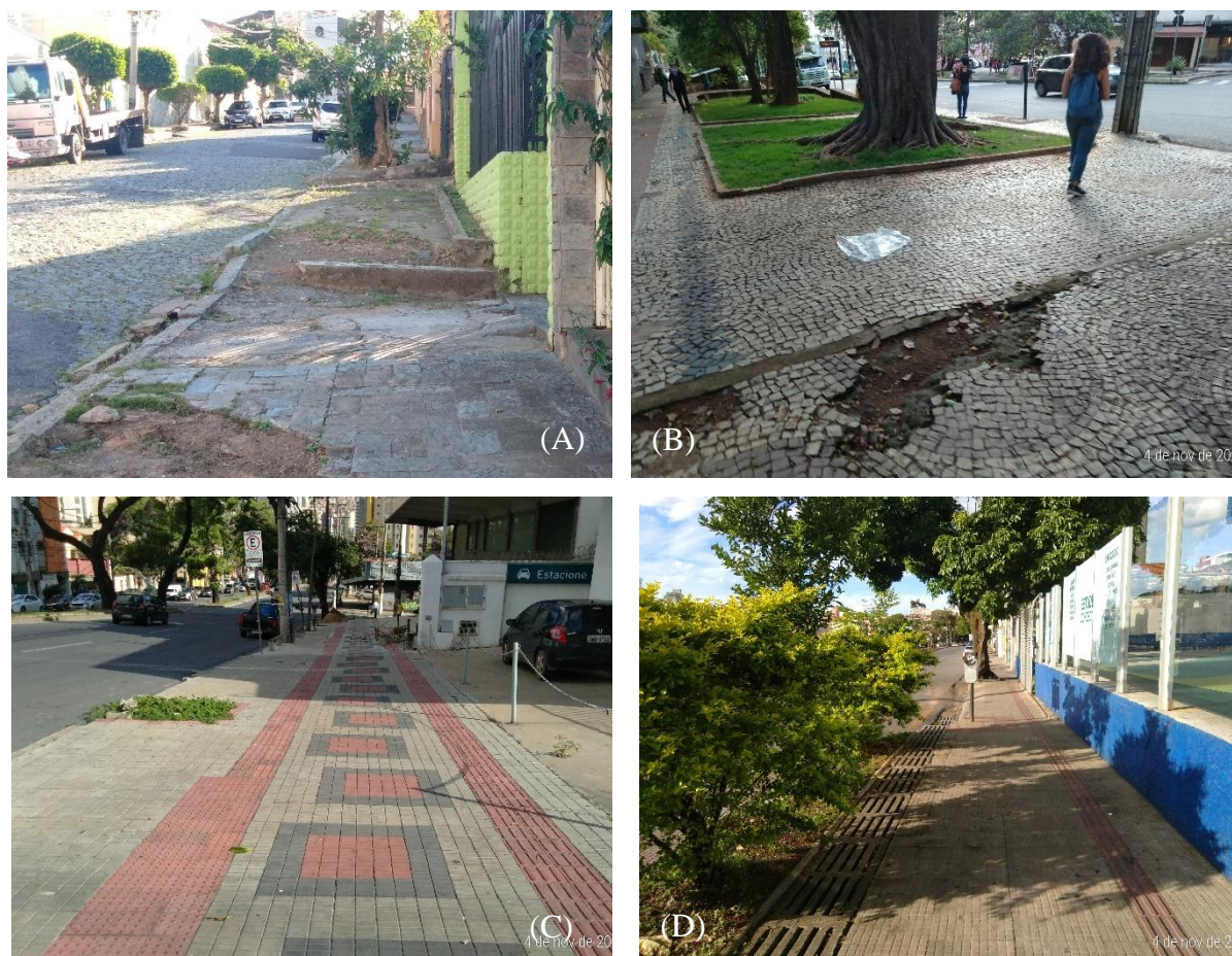
Figura D. 1 - Condição de pavimentação das calçadas
