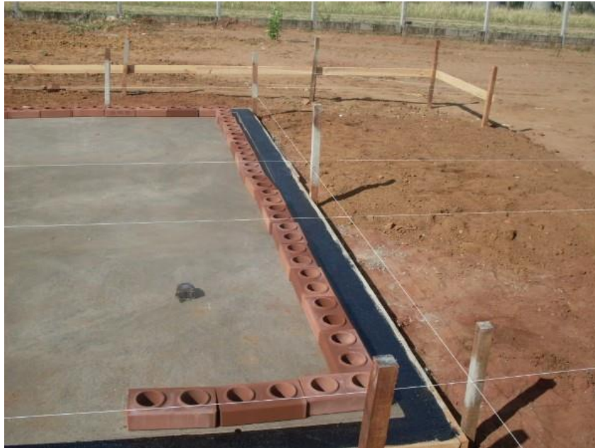
Figura 6: Espalhamento dos Tijolos.
