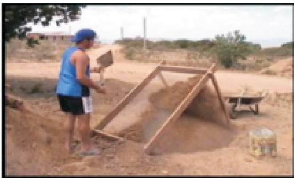
Figura 16: Peneiramento do Solo.
