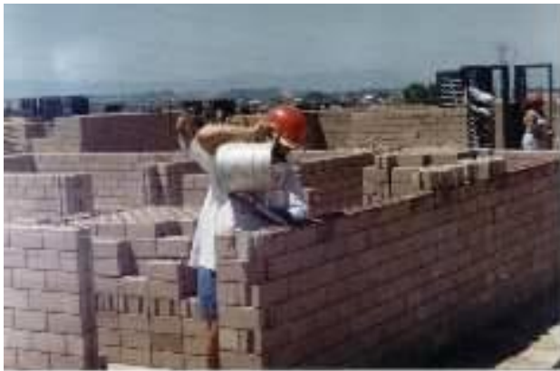
Figura 26: Execução do Grauteamento.
