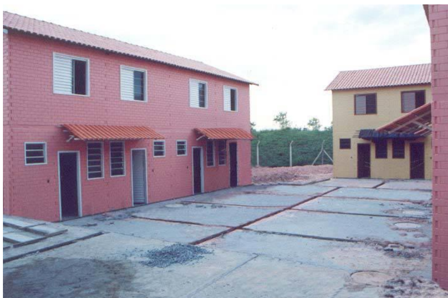
Figura 29: Edificações do Conjunto Granja de Freitas III.
