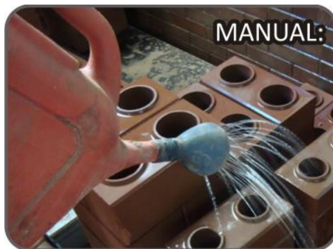
Figura 5: Processo manual de cura.
