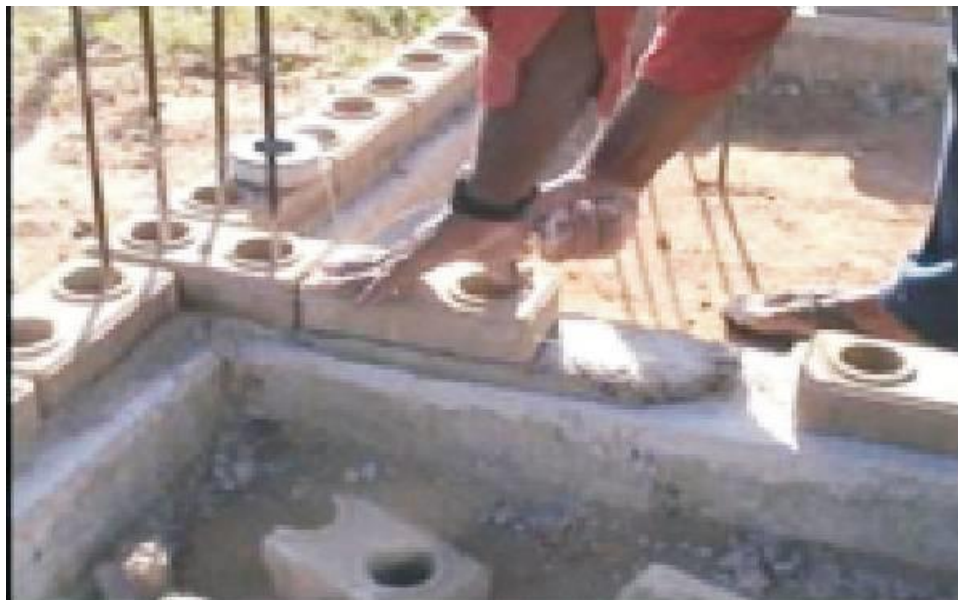
Figura 22: Execução da primeira fiada. Fonte: FERREIRA et. al., 2007.
