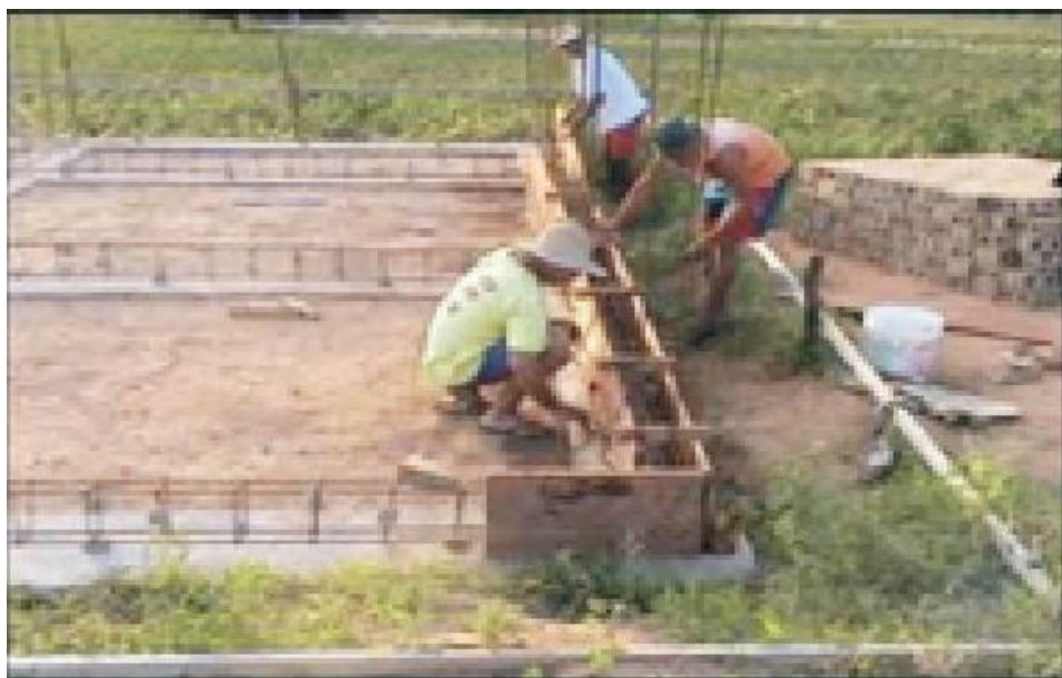
Figura 18: Execução das Vigas Baldrames.
