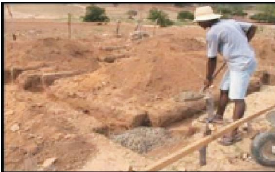
Figura 17: Execução das Sapatas.
