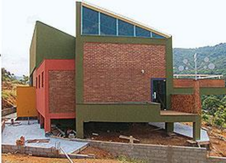
Figura 31: Prédio em alvenaria de solo-cimento
