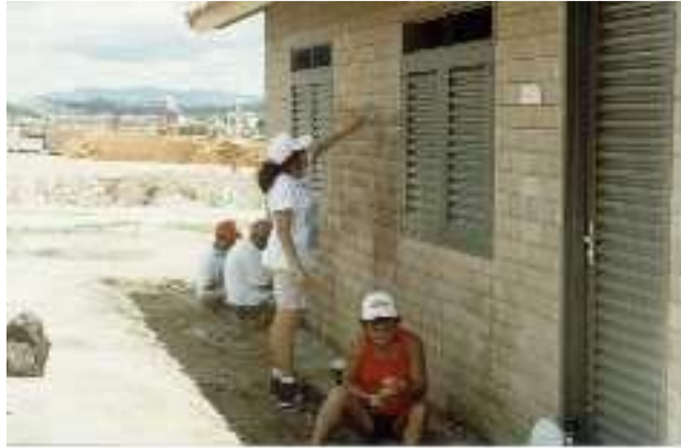
Figura 25: Execução do Rejuntamento.
