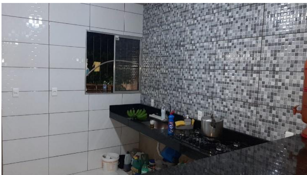
FIGURA 43 – Revestimentos da casa do Ari. FONTE: Foto de autoria do construtor Ari. Arquivo da disciplina “O desenho do canteiro”
