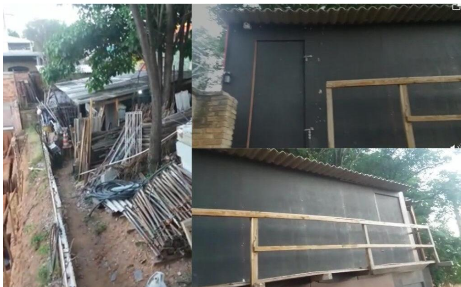
FIGURA 31 – Instalações do canteiro de obras FONTE: Fotos de autoria do construtor Marciano. Montagem da discente Diandra. Arquivo da disciplina “O desenho do canteiro”
