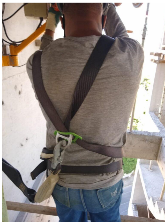
FIGURA 26 – Operador de guincho usando cinto de segurança. FONTE: Foto de autoria do construtor Roger. Arquivos da disciplina “O desenho do canteiro”.
