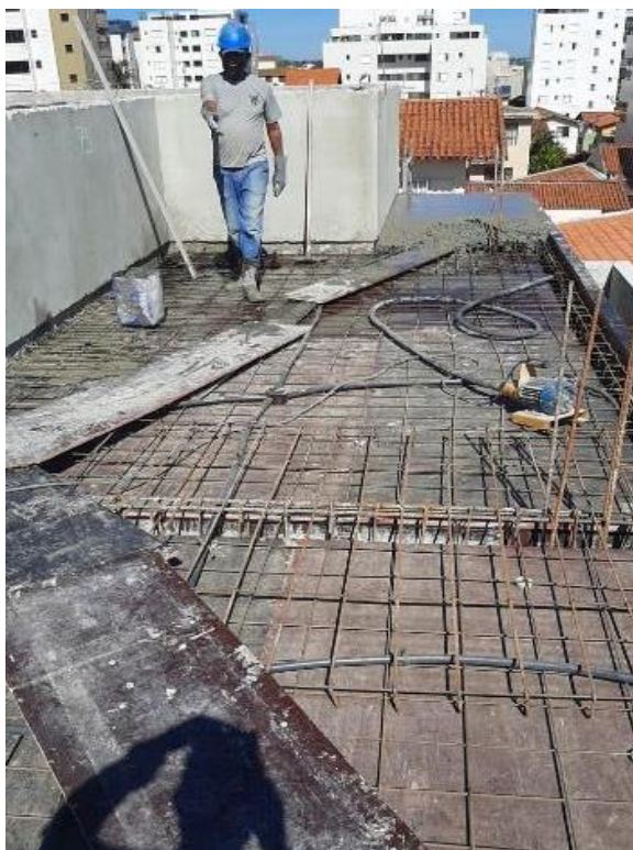
FIGURA 37 – Recortes de madeirite para facilitar a passagem. FONTE: Foto de autoria do construtor Ari. Arquivo da disciplina “O desenho do canteiro”.
