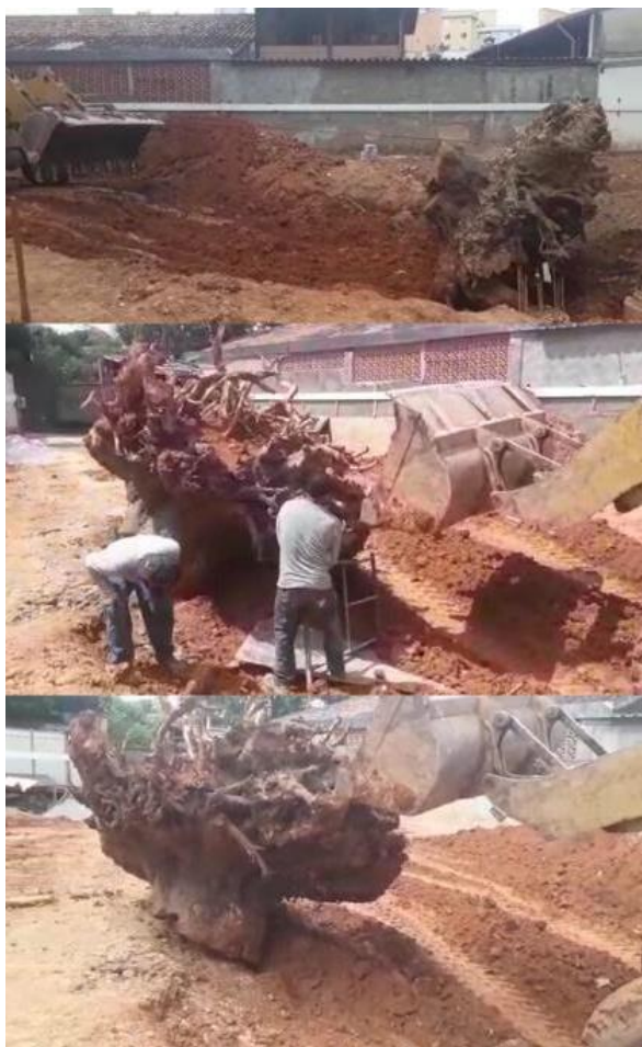
FIGURA 34 – Removendo uma raiz de mangueira.
