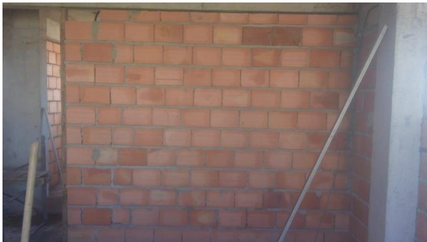
FIGURA 16 – Parede executada por Orlando. FONTE: Foto de autoria do construtor Orlando. Arquivo da disciplina “O desenho do canteiro”
