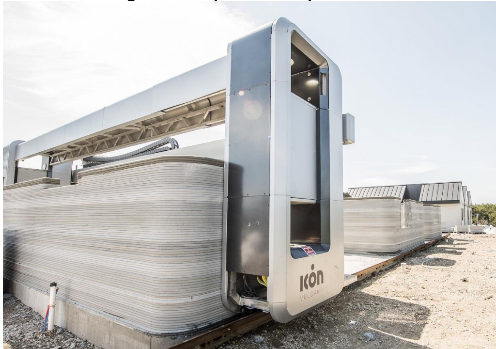
Figura 17 - Impressora 3D para casas
