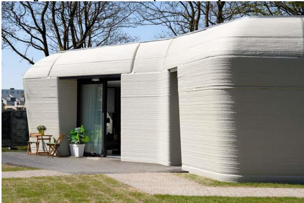
Figura 16 - Primeira casa impressa do Project Milestone
