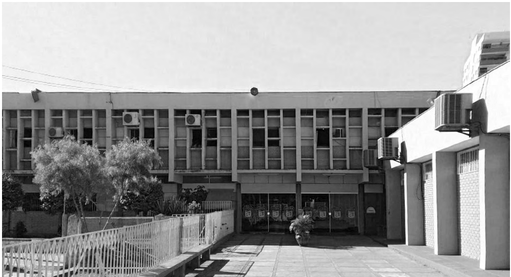
Fig. 6 - Obra Seminal - Escola Normal Oficial de Montes Claros, MG (FOTO: Amaro Sérgio Marques).
