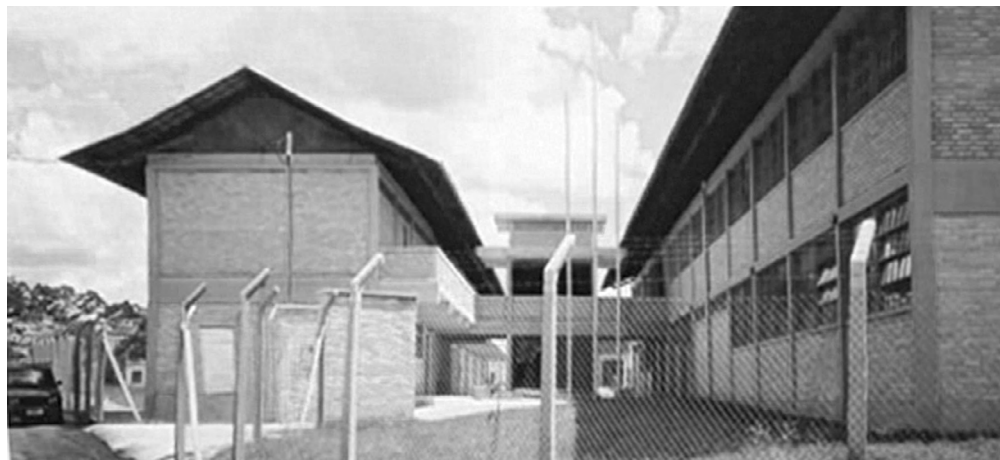
Fig. 9 - Escola Padrão 4 CARPE em 2 pavimentos – (FOTO: Construtora Marco XX).
