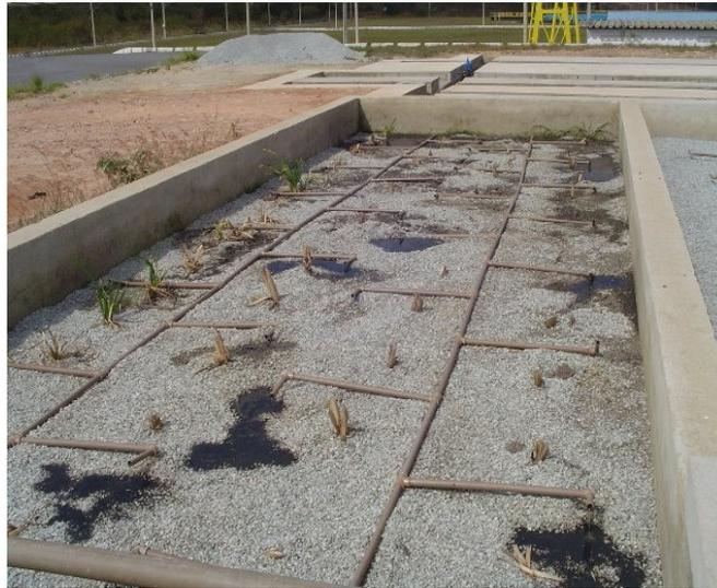
**Figura 5.1** – Amarelecimento das folhas, desenvolvimento ruim da taboa e má distribuição do esgoto bruto no filtro, imediatamente após a batelada.
