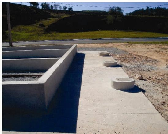
**Figura 4.8** – Caixas de passagem, que recebem o efluente tratado de cada filtro.
