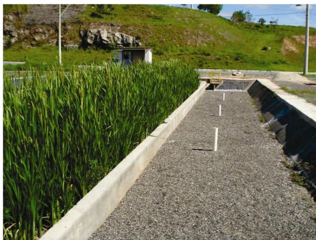
**Figura 4.11** – Sistema de *wetlands* subsuperficiais existente na área do CePTs, de onde foram retiradas as mudas de taboa.
