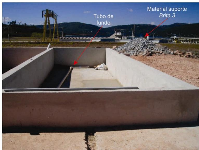
**Figura 4.3** – Fundo do filtro após aplicação da camada de massa de cimento – Detalhe da tubulação de drenagem de fundo (100 mm) instalada posteriormente no centro da unidade.
