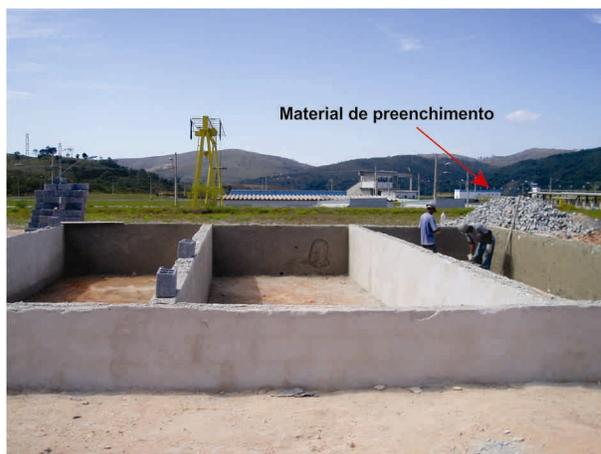
**Figura 4.1** – Detalhe dos três leitos filtrantes em construção.
