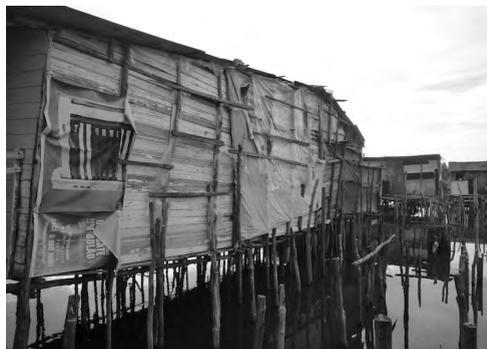
Fig.10 Remendos na parede lateral de palafita. (2012).
