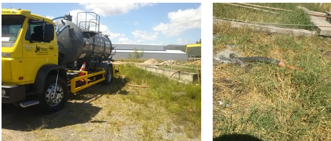
Figura 4.1 - Descarga de lodo de esgoto sanitário de tanque séptico no SAC-EV
