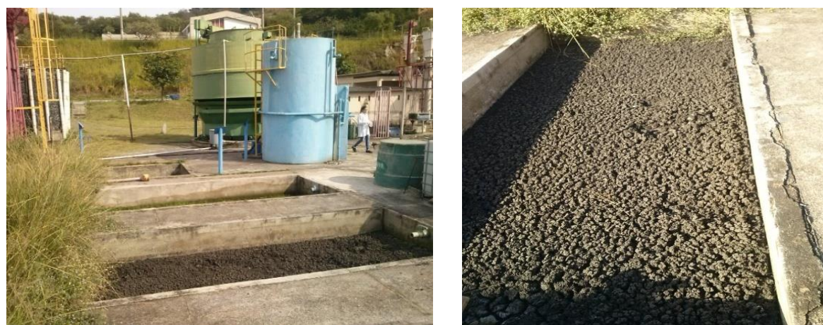
Figura 4.4 - Lodo de reator UASB
