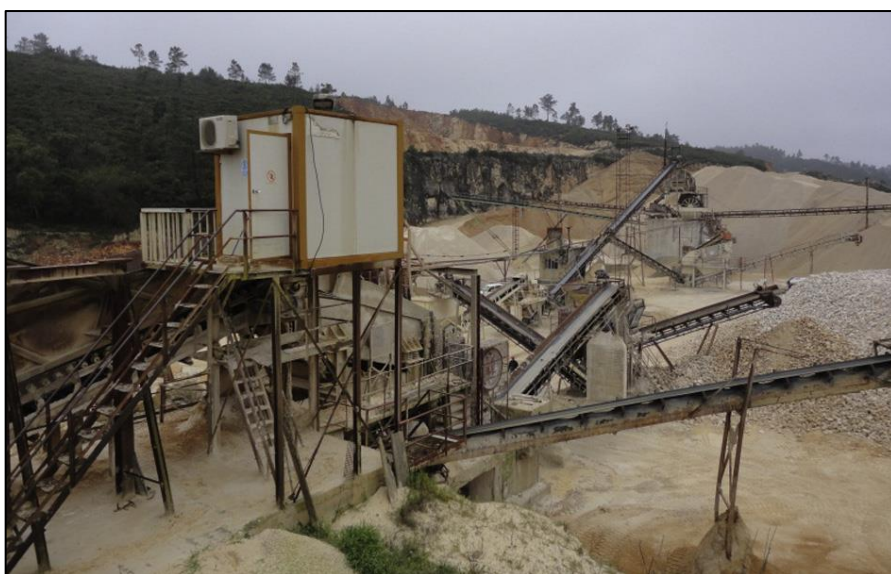
Figura 3.2 - Equipamento de britagem primária e secundária: Triturador de impacto e moinho de martelos Fonte: PEDRO et al. , 2014, p.144.
