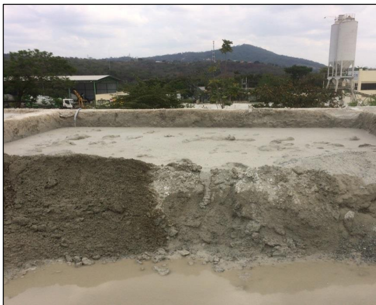
Figura 3.4 - Lama residual de concreto usinado
