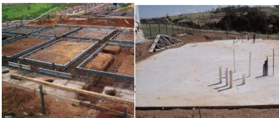
Figura 11 – Fundação do tipo sapata corrida.
