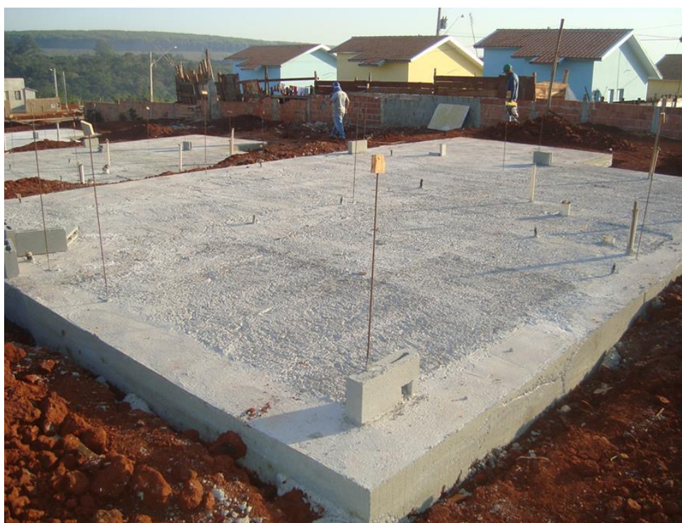
Figura 10 – Fundação do tipo laje Radier.
