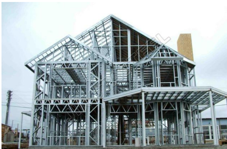
Figura 2 – Residência em Light Steel Frame .
