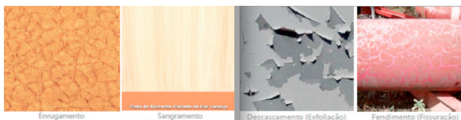
Figura 12: Patologias em tintas aplicadas sobre estruturas metálicas
